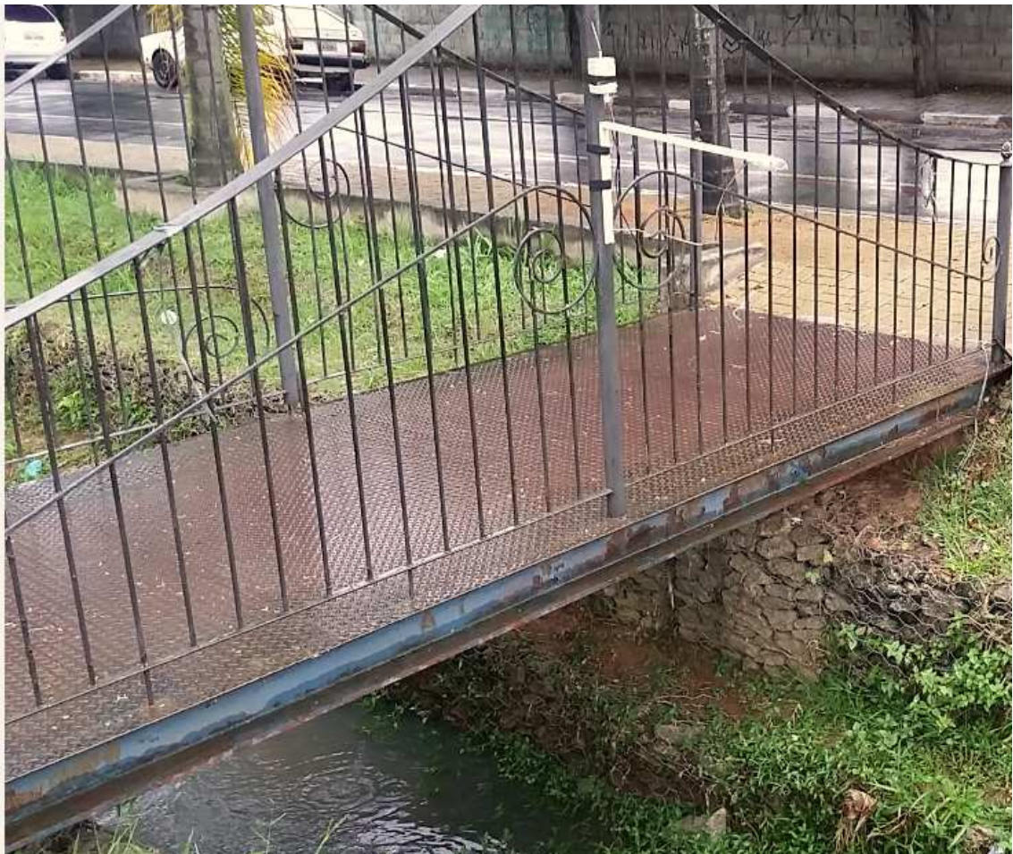
Figura 21. Instalação do Nó Sensor.
