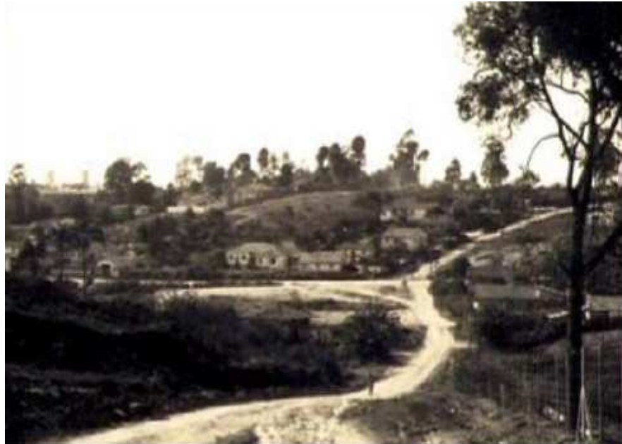
Figura 30. Área Central, Local Onde Foi Instalada a Ferrovia.
