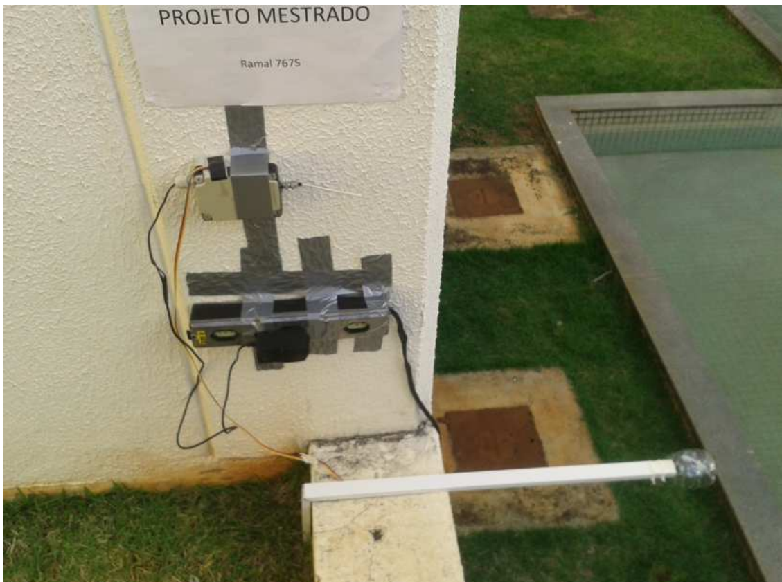
Figura 17. Instalação do Projeto – CEATEC.
