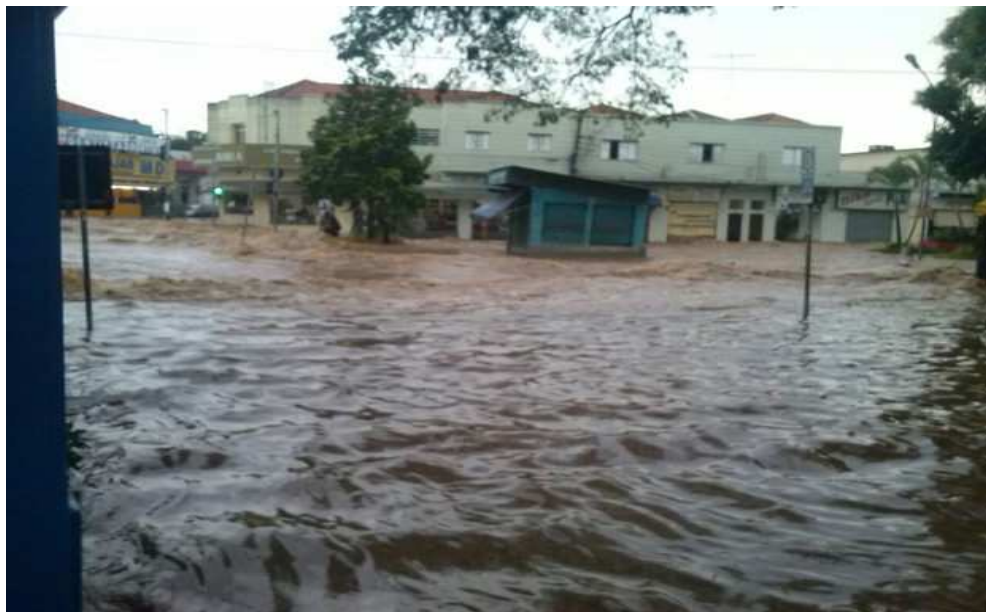
Figura 34. Alagamento no Centro de Poá.
