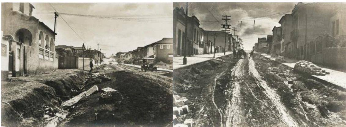
Figuras 65 e 66: Pavimentação e construção de calçadas Rua da Consolação, 1920. Fonte: AHSP
