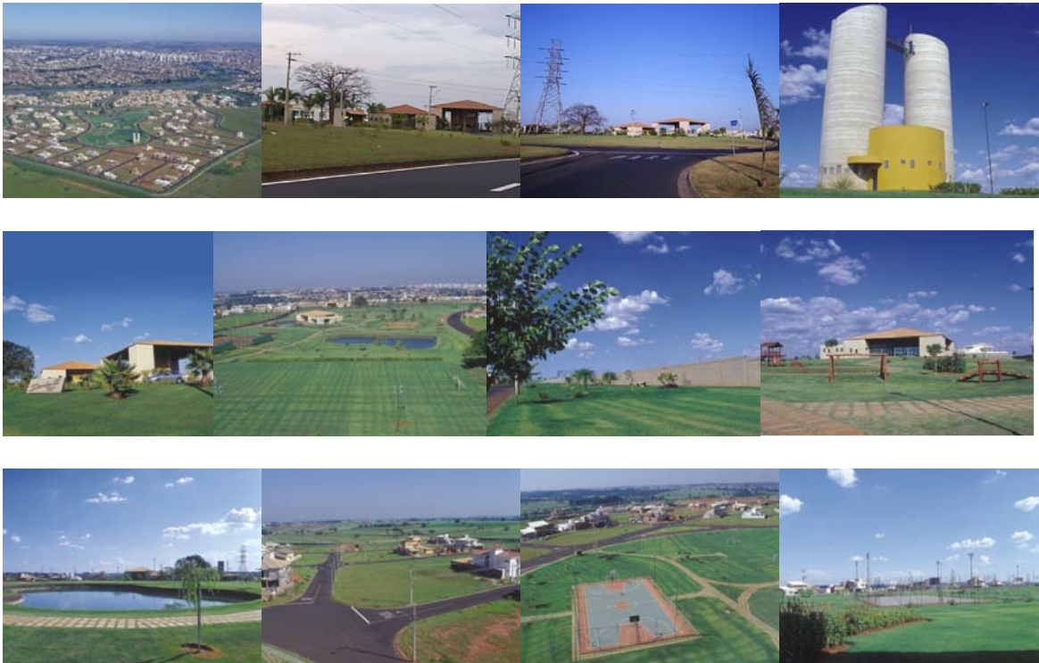
Figura 10: Fotos do Condomínio Residencial Márcia Fonte: Encalco, 2006.
