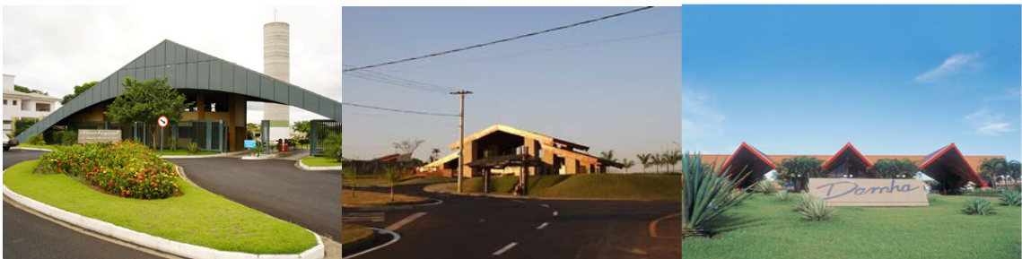
Figura 44: Fachadas dos Loteamentos Fechados
