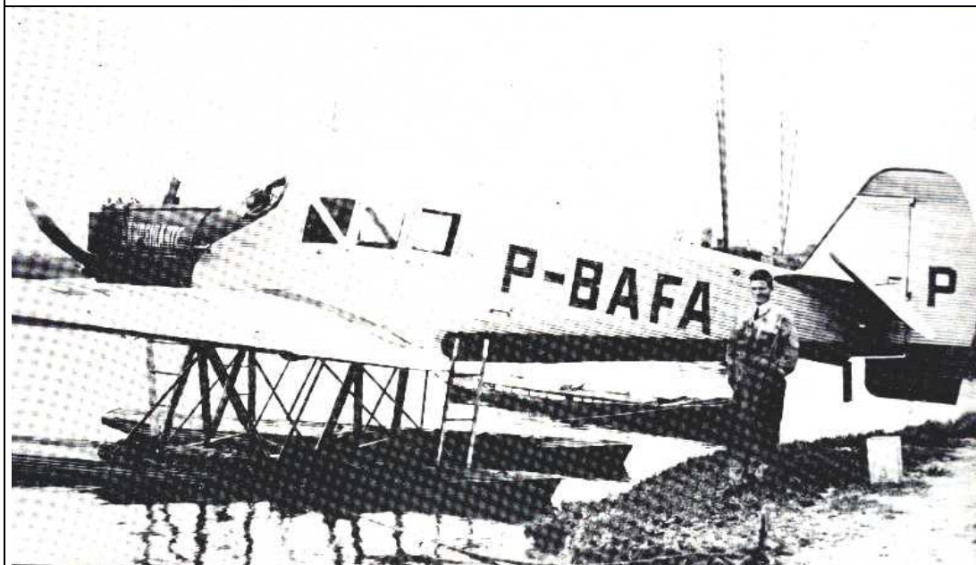
Figura 4: Os hidroaviões não dependiam de pistas de pousos, o que facilitava suas operações. Na foto um Junkers F 13. Década de 30.
