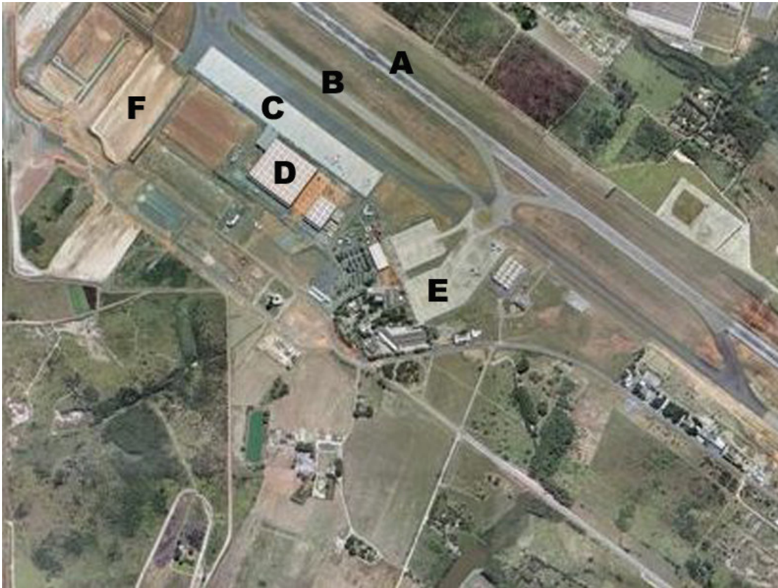
Figura 22: Vista aérea mostrando a pista (A) do Aeroporto Internacional de Viracopos e, paralelamente, a área de táxi (B), estacionamento de aeronaves (C), estação de passageiros (D) e demais prédios de escritórios (E) e depósitos (F). Base Aerofotogrametria Ltda. 2001.
