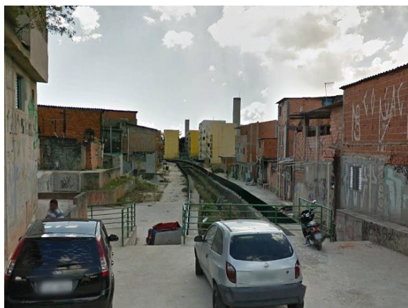
Figura 4.18 – Trecho com ausência de iluminação pública. Fonte: Google Imagens 2017.
