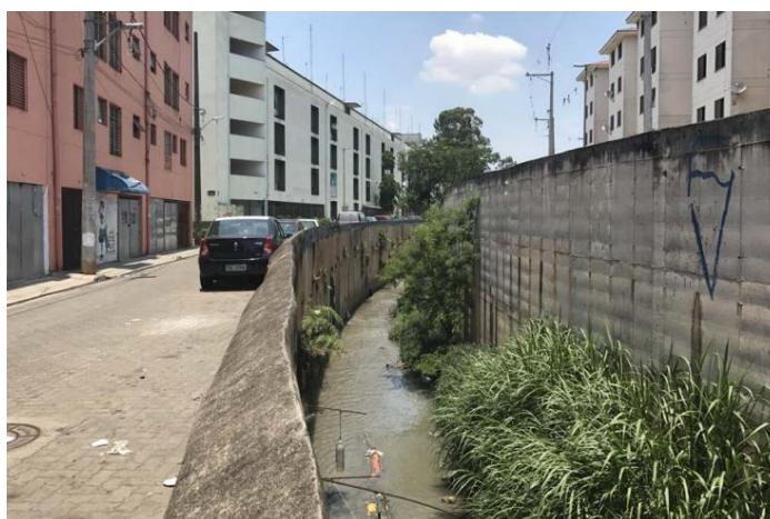
Figura 2.11 – Canalização do córrego Sacomã em vala profunda entre vias. Fonte: LUCCIA, 2018.
