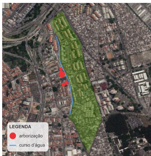
Figura 4.6 – Arborização ao longo do córrego Sacomã. Fonte: elaboração própria sob foto aérea do Google Earth 2018.
