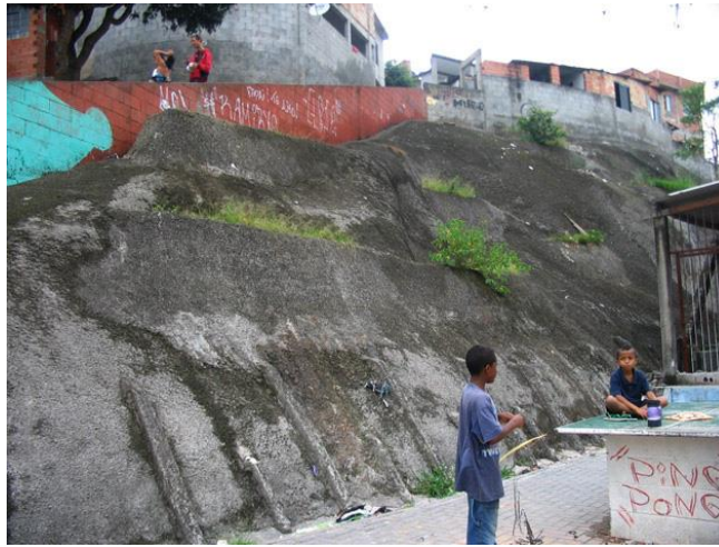
Figura 2.25 – Concreto projetado para estabilização das encostas. Fonte: GROSBAUM, 2012.
