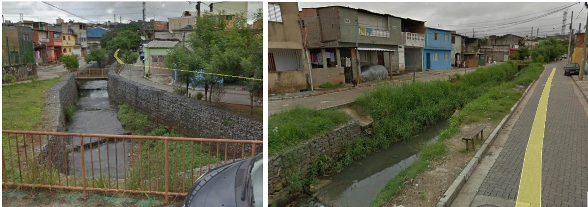
Figura 2.37 – Situação atual do córrego Bento Henriques, canalização aberta com contenções de gabião. Fonte: Google Imagens, 2018.
