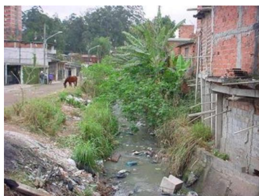
Figura 2.43 – Situação anterior à urbanização em 2003. Fonte: PULHEZ, 2007.
