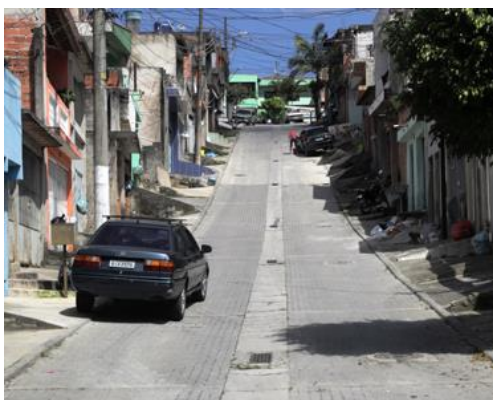
Figura 2.61 – Solução de permeabilidade do solo para as vielas. Fonte: SOLUÇÕES PARA CIDADES, [201-].
