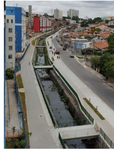
Figura 2.68 – Solução de macrodrenagem adotada. Fonte: Corte esquemático - BASE URBANA, 2014 / Imagem - BRANDÃO; LEITÃO, 2017.
