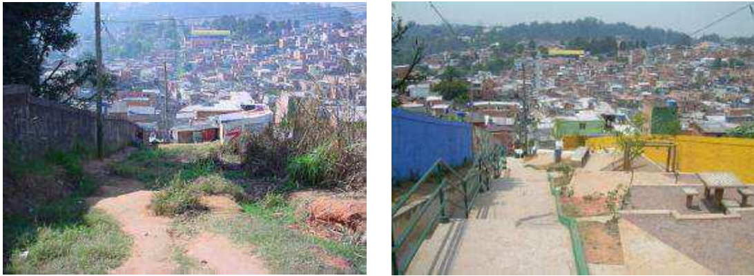
Figura 2.75 – Escadaria Antonico antes e depois das obras. Fonte: CASTILHO, 2012.
