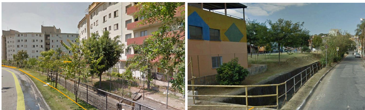
Figura 2.52 – Trechos de canalização aberta do córrego Olaria. Fonte: Google Imagens, 2018.
