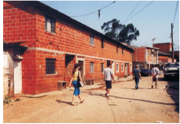
Figura 2.32 – Tipologia das moradias construídas em mutirão – FUNAPS, no setor 3, rua Silva Ortiz. Fonte: USINA / TEIA, 2004.
