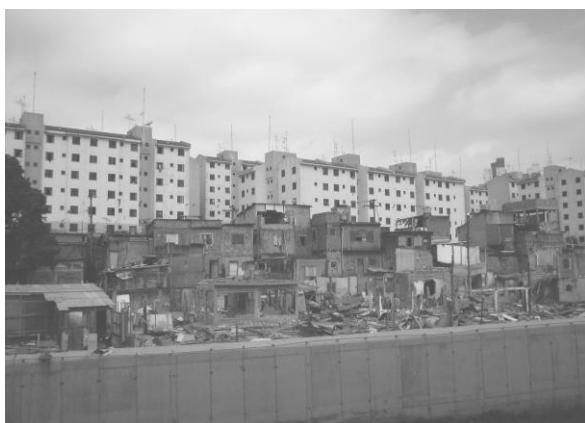
Figura 2.9 – Conjunto PROVER / Cingapura com vista para ocupação remanescente. Fonte: ALBUQUERQUE, 2004.
