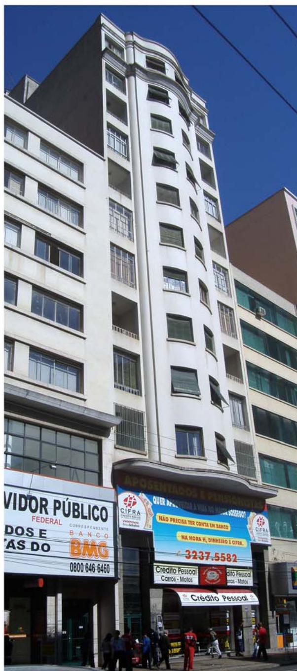
Edifício de Apartamentos do Banco Bandeirantes do Comércio S/A foto: Caio Ferreira 2006
