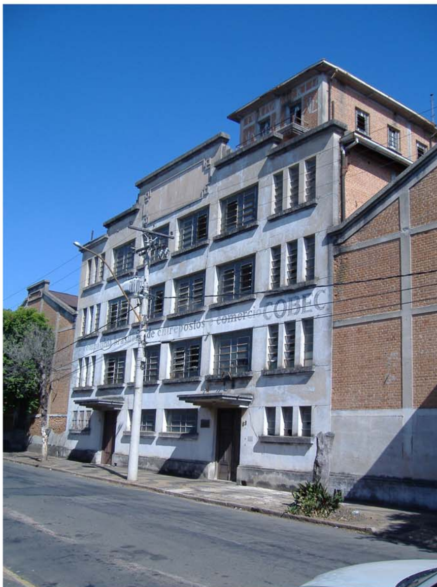
3º edifício - Usina de Benefício e Padronização de Café - foto: Caio Ferreira 2006
