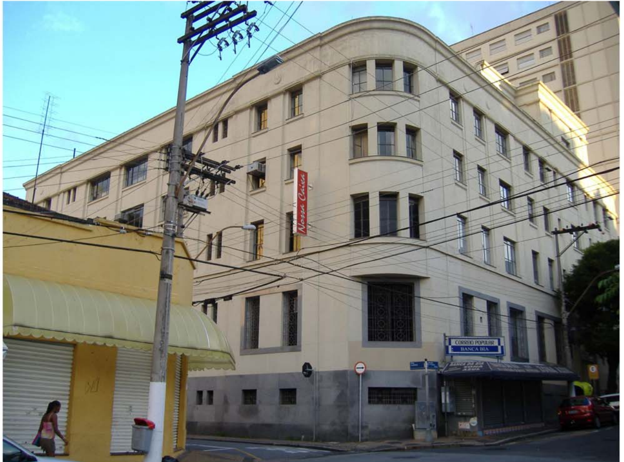
Ampliação do edifício da Caixa Econômica Estadual - foto: Caio Ferreira 2006
