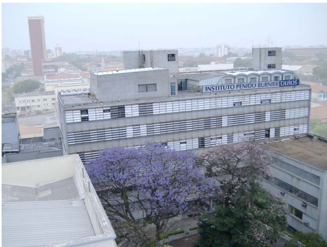
Fachada oeste - foto: Caio Ferreira 2006
