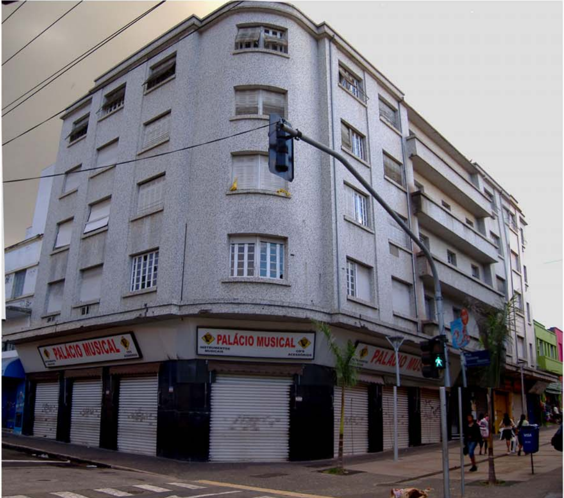
5º Edifício - Valverde - foto: Caio Ferreira 2006
