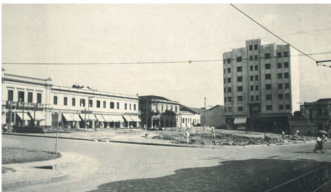
Foto do edifício na década de 40 - fonte Arquivo MIS
