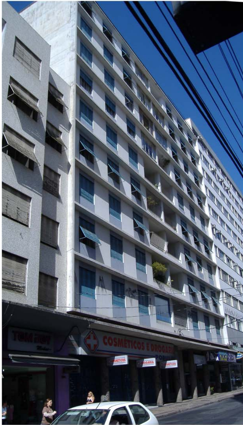
Edifício Tônico Ribeiro - foto: Caio Ferreira 2006
