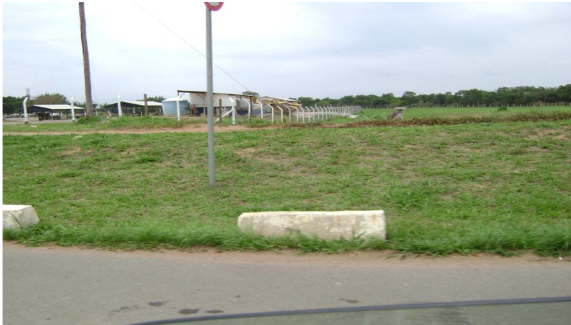
FIGURA 28 - O abandono do canteiro de obras.
