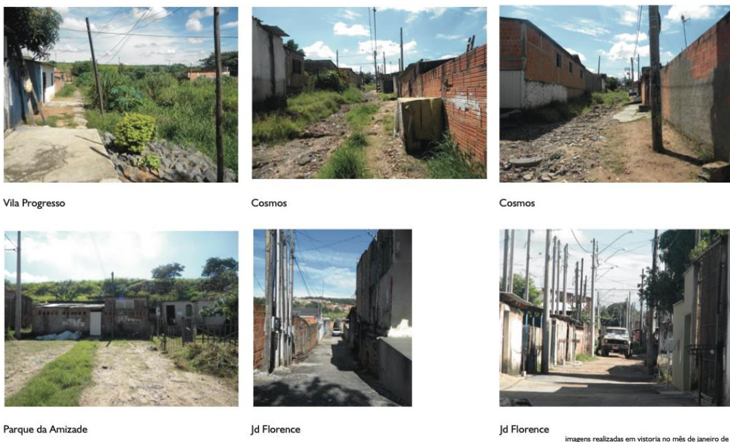
Figura 22: Imagens realizadas em vistoria no mês de Janeiro de 2011.
