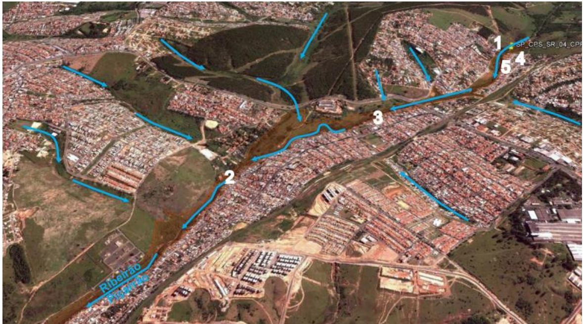
Figura 19: Locais considerados de risco pela Defesa Civil no JF II.
