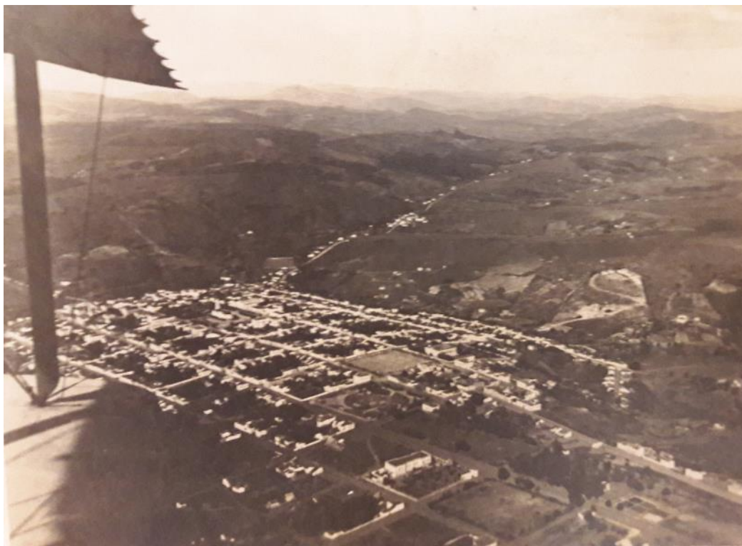
Figura 37 Vista aérea de São José do Rio Pardo em 1921. O tecido urbano, em malha ortogonal, ramifica-se em direção a um caminho que liga o município a Caconde. Era a mesa rota que desde o século XVII dava acesso ao Sul de Minas Gerais, através do município de Cabo Verde. FONTE: Centro de Memória Rio-pardense.
