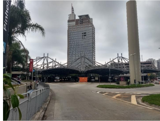
Em sentido horário: Figura 3.1: Terminal Intermodal Rua Capri.
