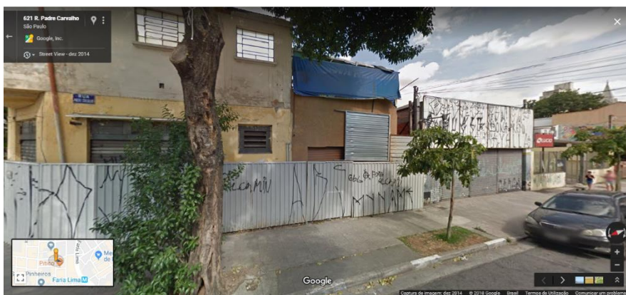
Figura 3.35: Rua Padre Carvalho - Tapumes isolando a área. Fonte: Google Street View, Dezembro de 2014.
