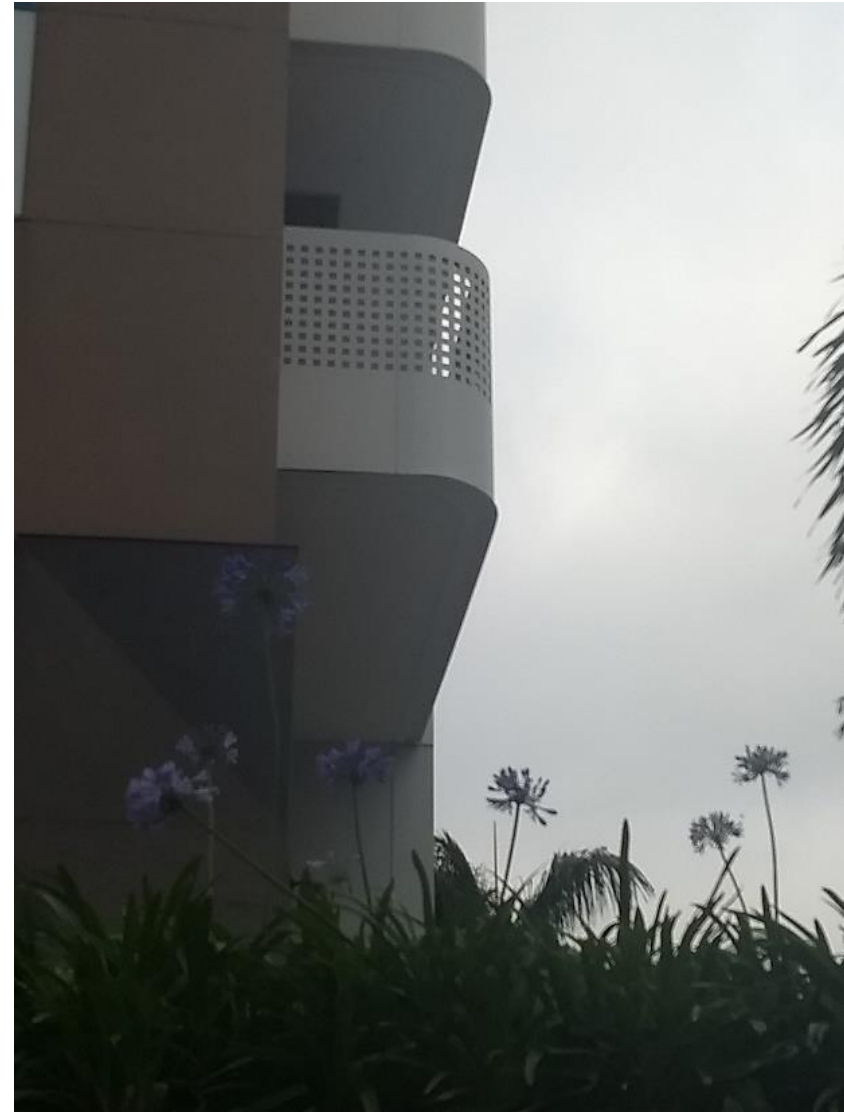
Figura 4.8: Elementos sólidos, vazados e vegetação. Fonte: Foto da autora, Nov. 2018.
