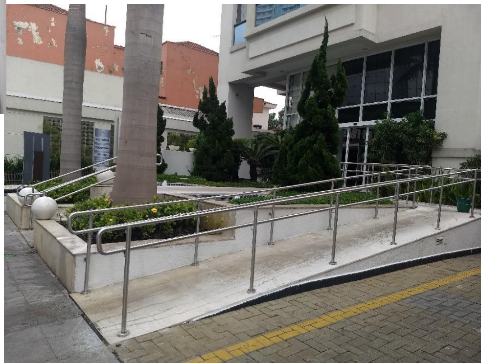
Figura 4.10: Rampa – acessibilidade. Fonte: Foto da autora, Nov. 2018.
