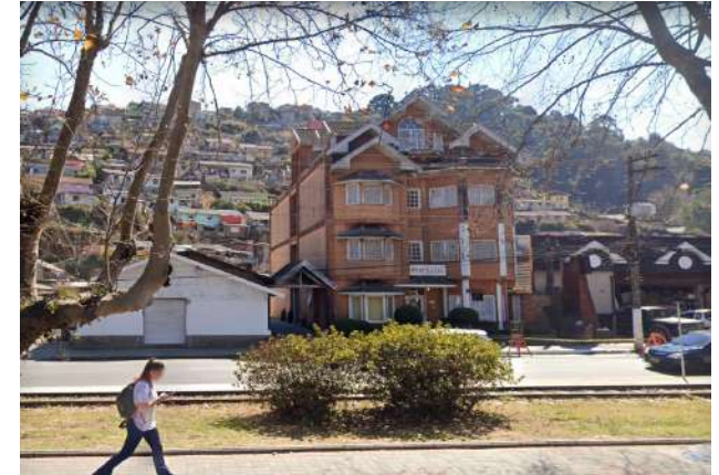
Figura 02: Visão da Av. Januário Miraglia fonte: Google Street View
