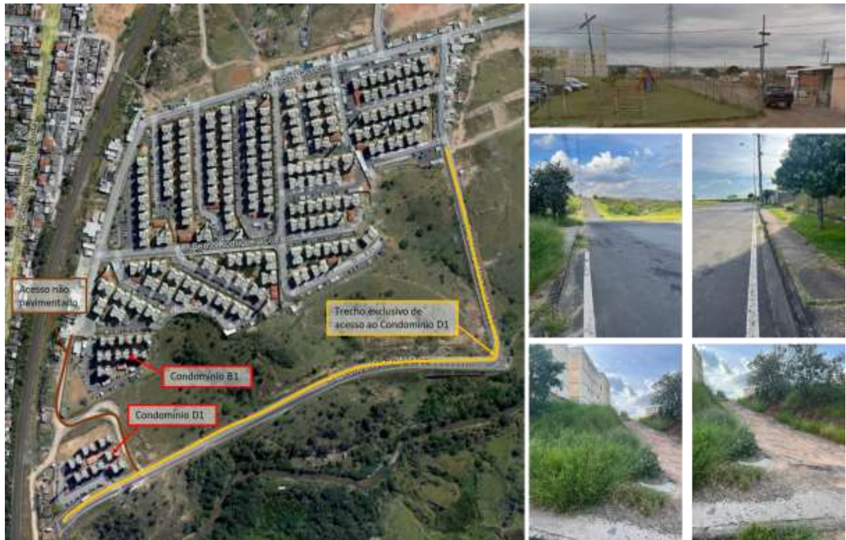
Figura 19 – Acesso ao Condomínio D1
