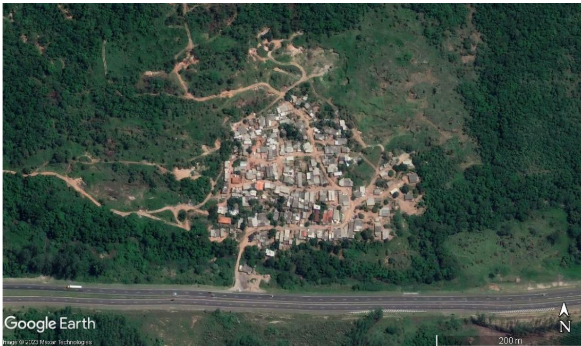
Figura 63: UMT–03. Assentamento precário. Aspecto de sua ocupação.
