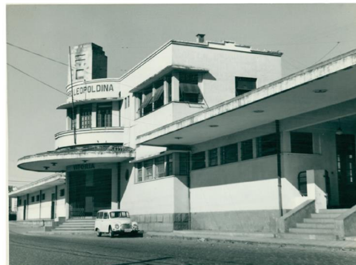
Fachada Estação Leopoldina
