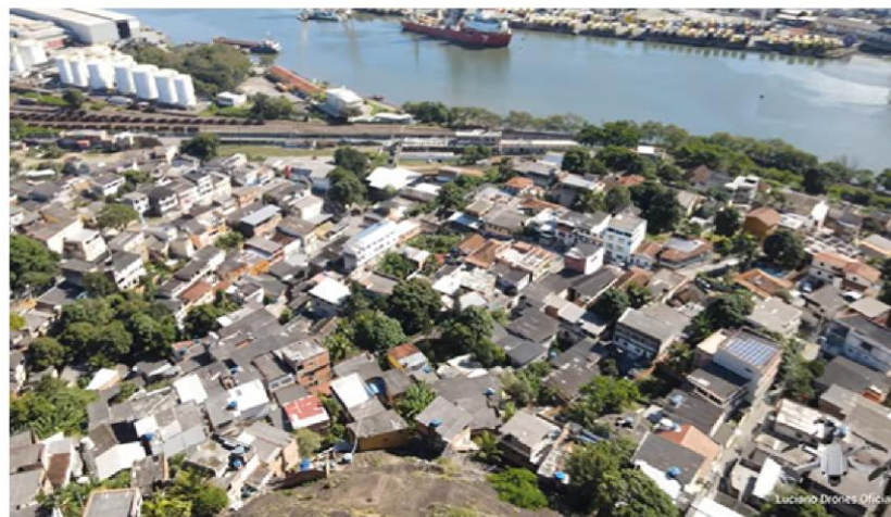
Vistas das casas para o Rio Santa Maria
