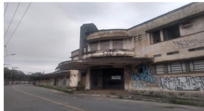
Fachada Estação Leopoldina- 17/11/2019
