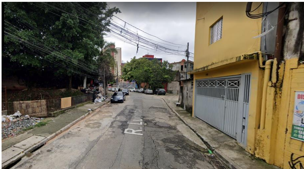
Figura 41 – Imagem da Rua Lucinda Gomes Barreto (tipologia VTVP2) Transposição (veículos e pedestres) - Via Pavimentada / Asfaltada.
