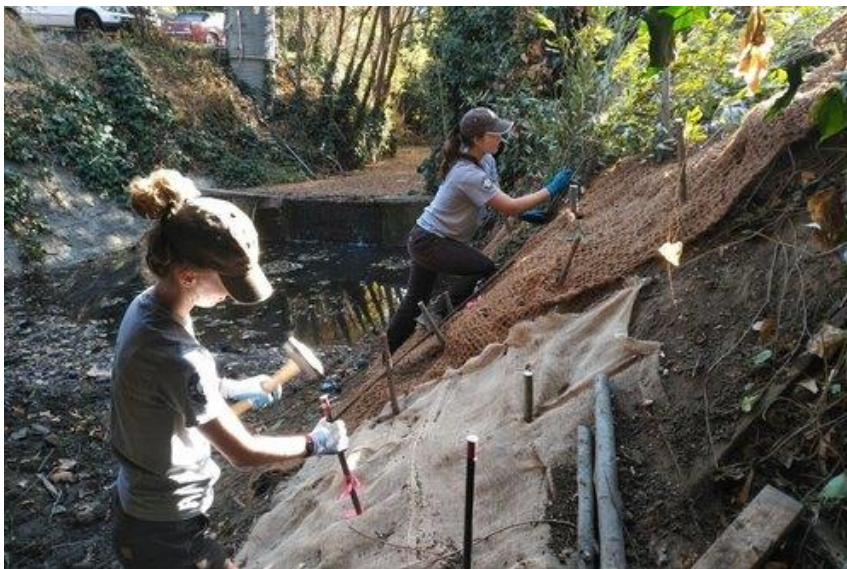
Figura 33 – Membros do Watershed Steward Program, utilizando bioengenharia em uma residência em Martínez, Califórnia, na atualidade, como parte do Programa SLMP — Streams Management Program for Landowners in Contra Costa County
