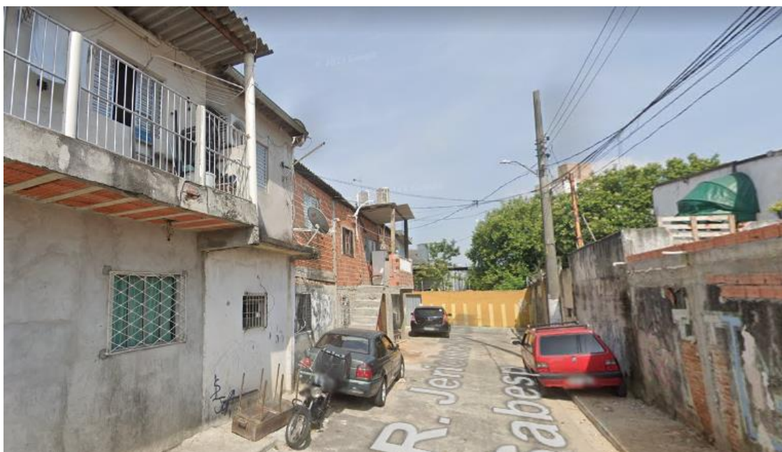
Figura 44 – Imagem da Rua Jericino - Travessa N1 e N2 (tipologia VCFA1) Conexão sem transposição - Via Pavimentada / Asfaltada - fechada para o córrego muro alto.
