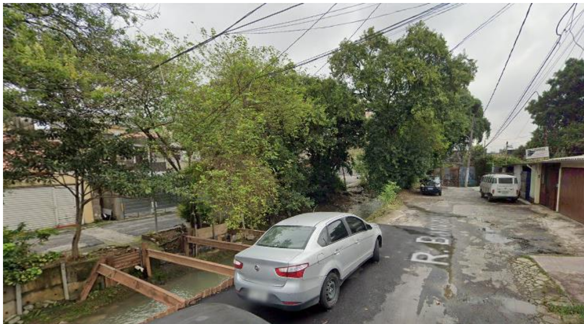
Figura 48 – Imagem da Rua Barvança (tipologia VCANS2) - Conexão sem transposição - Pavimentada / Asfaltada - aberta para o córrego sem sistema de proteção.
