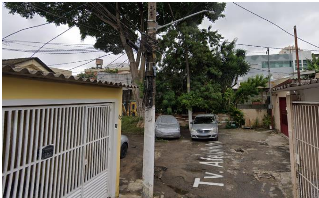
Figura 46 – Imagem da Travessa Afelandra (tipologia VCFP3) Conexão sem transposição - Via Pavimentada / Asfaltada - fechada para o córrego - tapumes de madeira.
