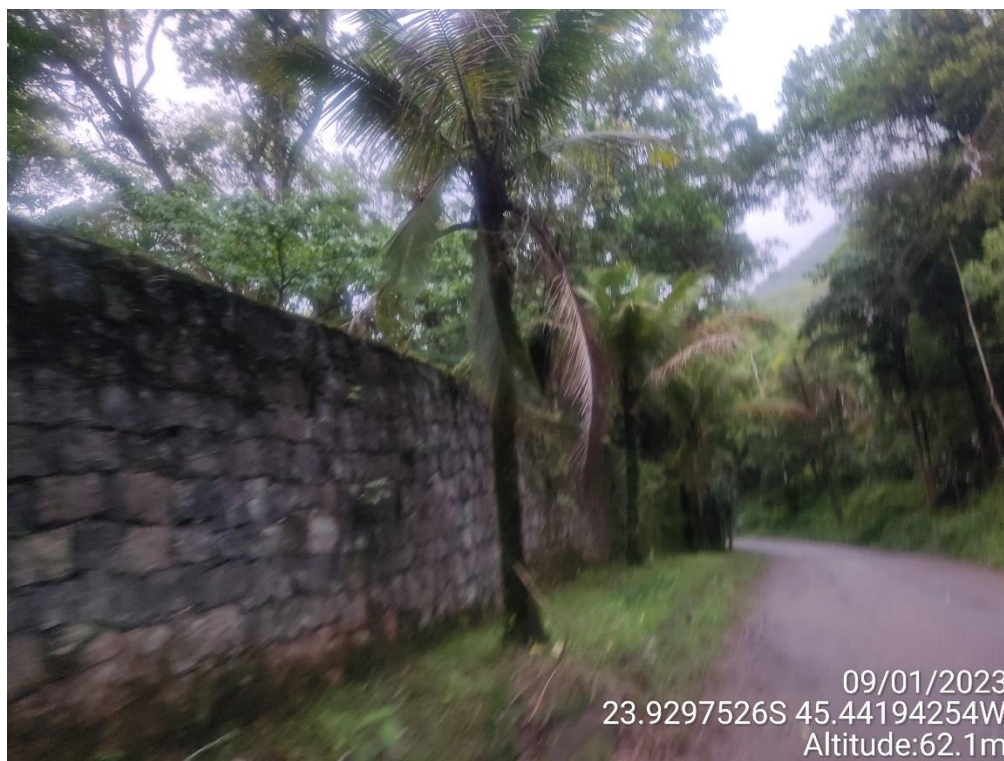
Figura 21 - Registro da encosta de Ilhabela, vista do mar bloqueada pela fachada de uma casa de uma pousada. Na lateral inferior direita se encontra a data do registro, as coordenadas do local e a altitude. Fonte: Acervo pessoal da autora, jan/2023.
