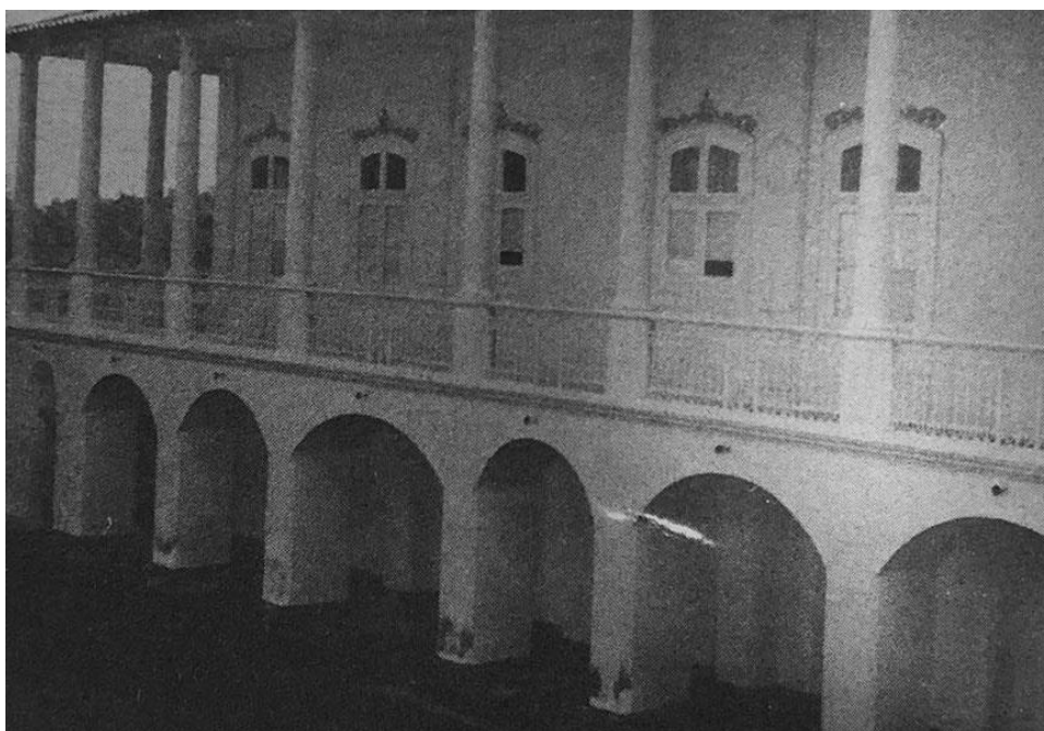
Figura 31. Alpendre de entrada para acesso à sede da fazenda Recreio (sem ano). Fonte: Pupo, 1983, p. 177.
