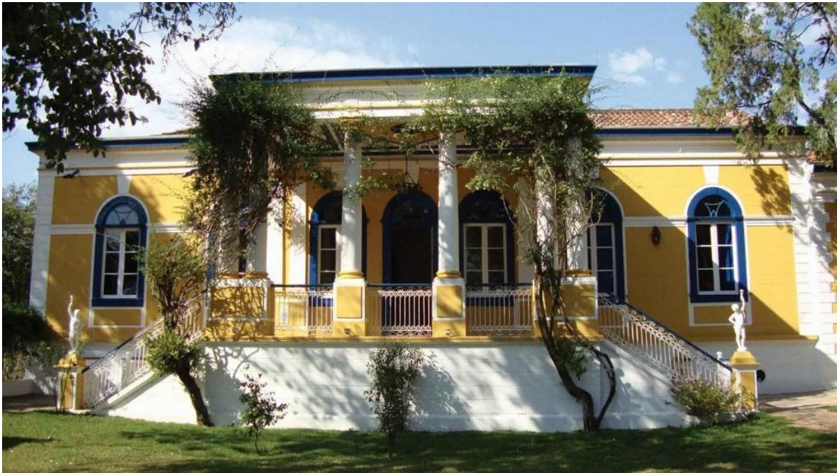
Figura 51. Sede da fazenda Pau d'Alho, localizada em Campinas. Fonte: Silvia Zákia in CONDEPACC, 2004. Disponível em: https://encurtador.com.br/koABQ . Acesso em nov. 2023.
