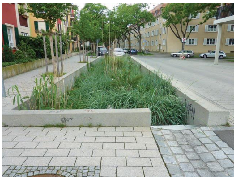
Figura 14. Canteiro pluvial no bairro de WhiereÖst, Freiburg - Alemanha.
