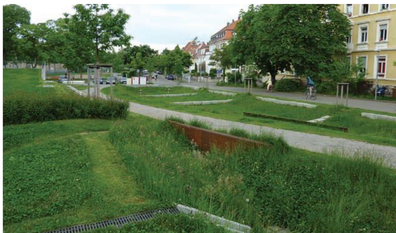
Figura 15. Jardim de chuva integrado (Wiehre, Freiburg, Alemanha).
