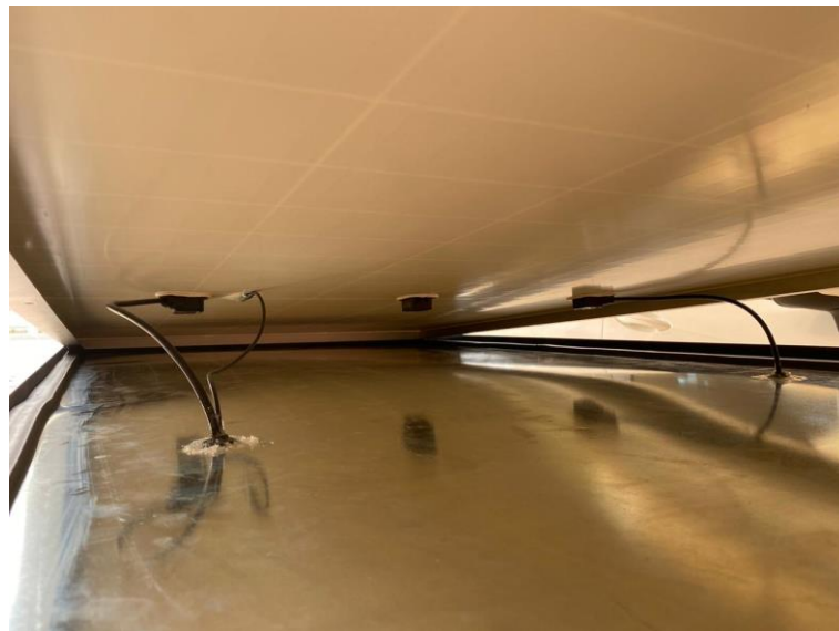
Figura 53. Passagem dos cabos
