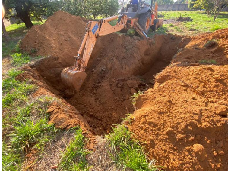
Figura 34. Abertura de buraco utilizando uma Retroescavadeira
