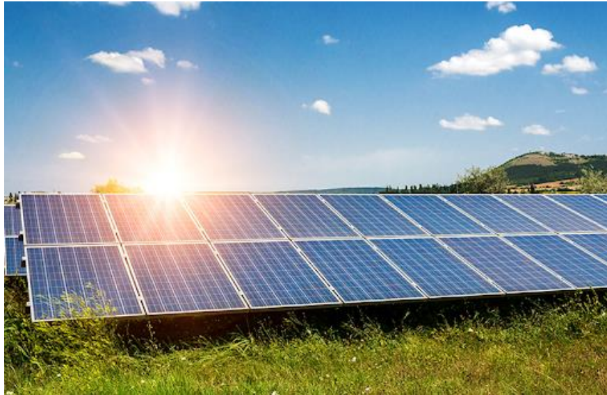
Figura 20. Exemplo de instalação no qual é necessário realizar roçagem
