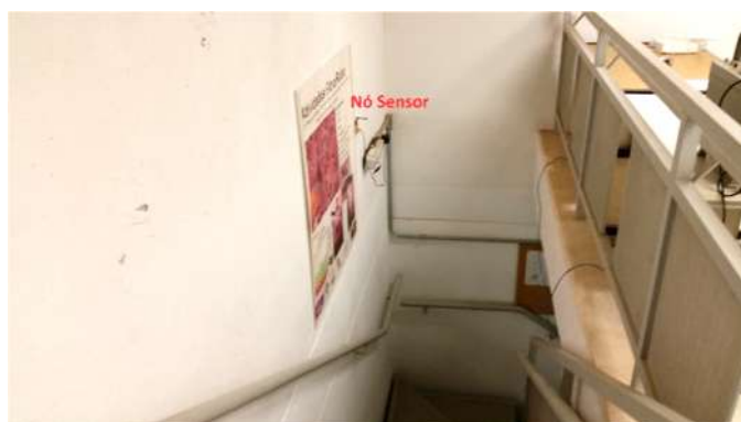
Figura 34: Foto do Ambiente de Teste – Nó Sensor na escada de acesso ao Piso 2
