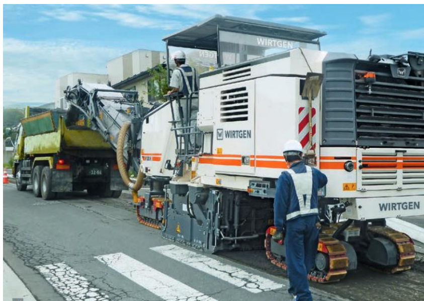
Figura 3.13 - Processo de fresagem asfáltica.
