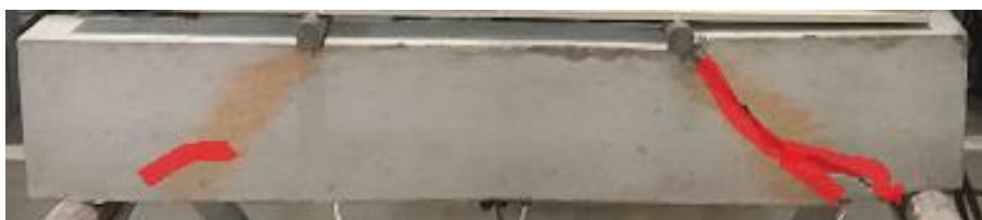
Figura 6.113 – TFAII SE – detalhes fissuras
