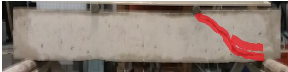
Figura 6.95– TFVI SE – detalhes das fissuras
