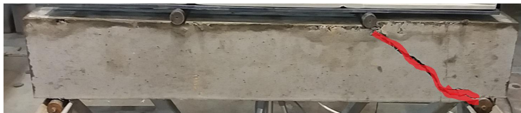
Figura 6.101 – TfvII SE – detalhes fissuras
