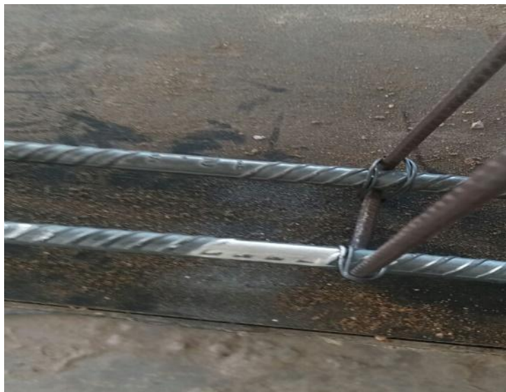
Figura 5.39 - Remoção das irregularidades da barra de aço.
