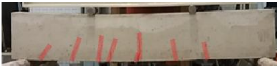
Figura 6.80 – TREF CE – detalhes fissuras
