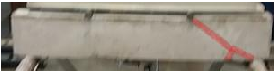
Figura 6.92 - - TFVI CE – detalhes das fissuras
