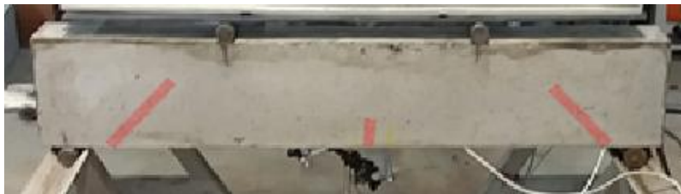
Figura 6.86 – TFRES CE – detalhes fissuras
