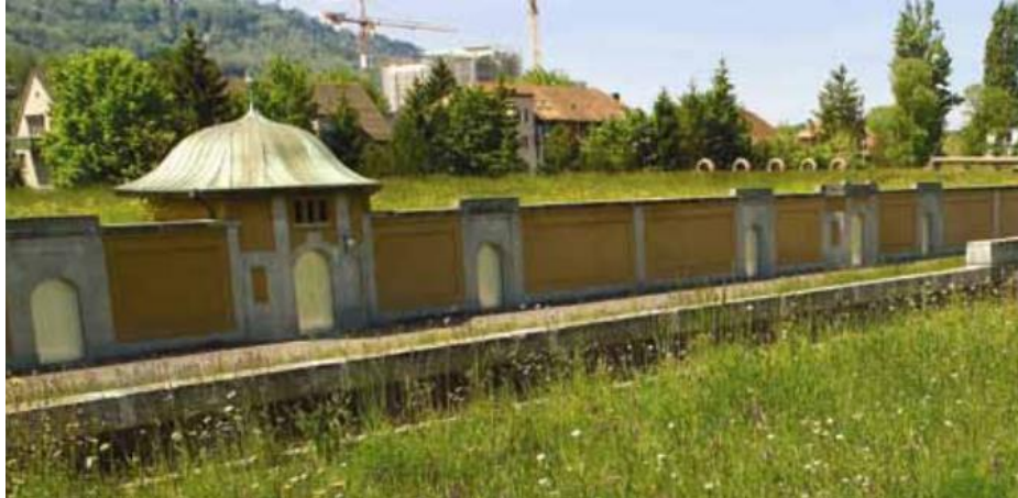
Figura 10. Telhado verde de Seewasserwerk Moos - em Wollishofen, Zurique, Suíça.
