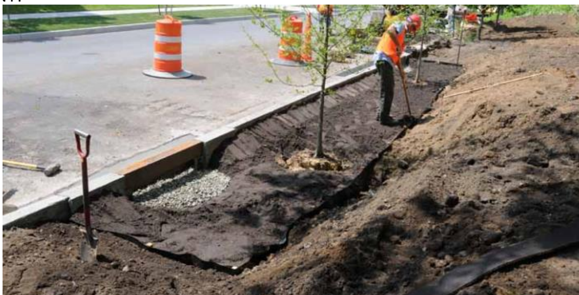
Figura 14. Construção de trincheiras de infiltração pelas ruas do bairro Brooklyn-NY.
