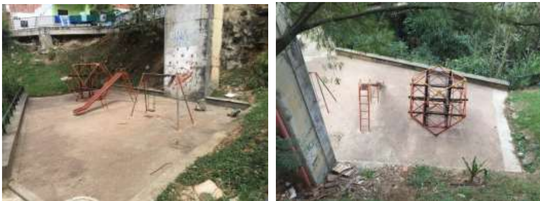
Figura 33: Fotos do Parquinho embaixo da ponte El Mirador. Estado atual.
