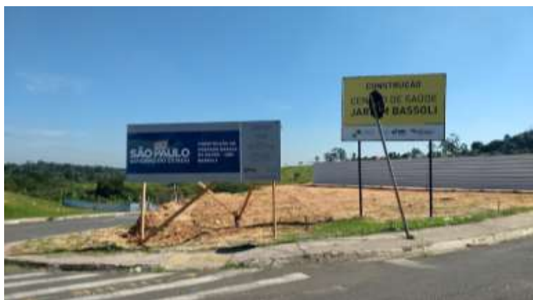
Figura 67: Foto da Placa indicando a construção do Centro de Saúde no Residencial Bassoli
