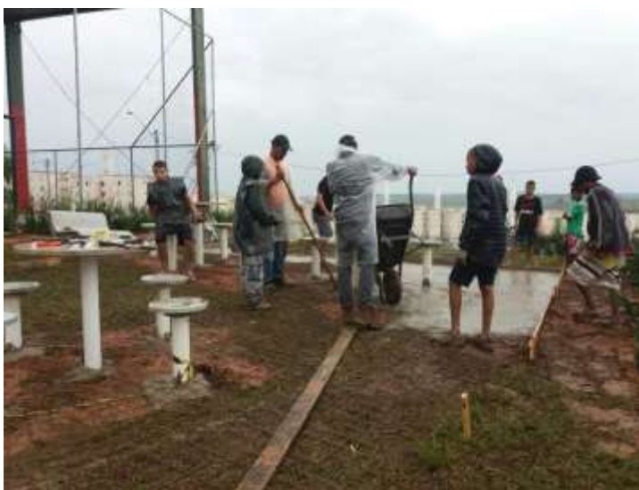
Figura 106: Foto da execução do piso e instalação dos bancos e mesas no Residencial Bassoli
