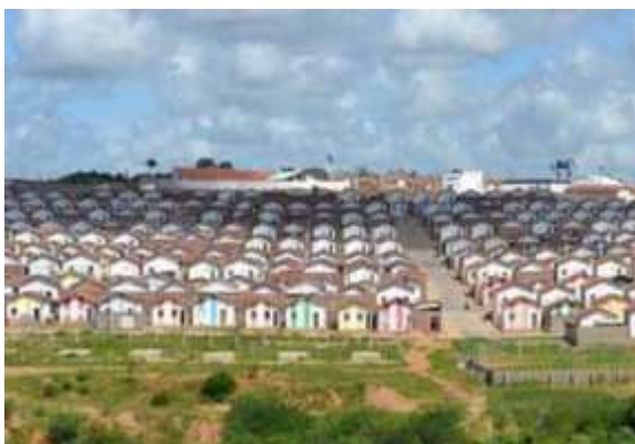
Figura 86: Foto do Residencial Brisa do Lago, em Arapiraca.
