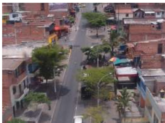
Figura 17: Foto da Calle 107 após a intervenção viária
