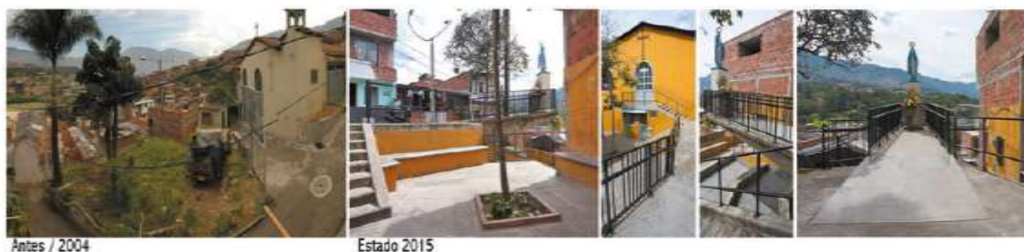
Figura 31: Fotos da Vila Niza: Antes e depois da Intervenção PUI.
