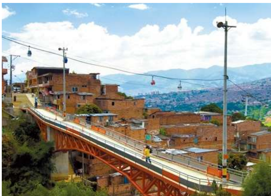
Figura 18: Foto da Ponte Pedestre Mirante Andalucía- La Francia.
