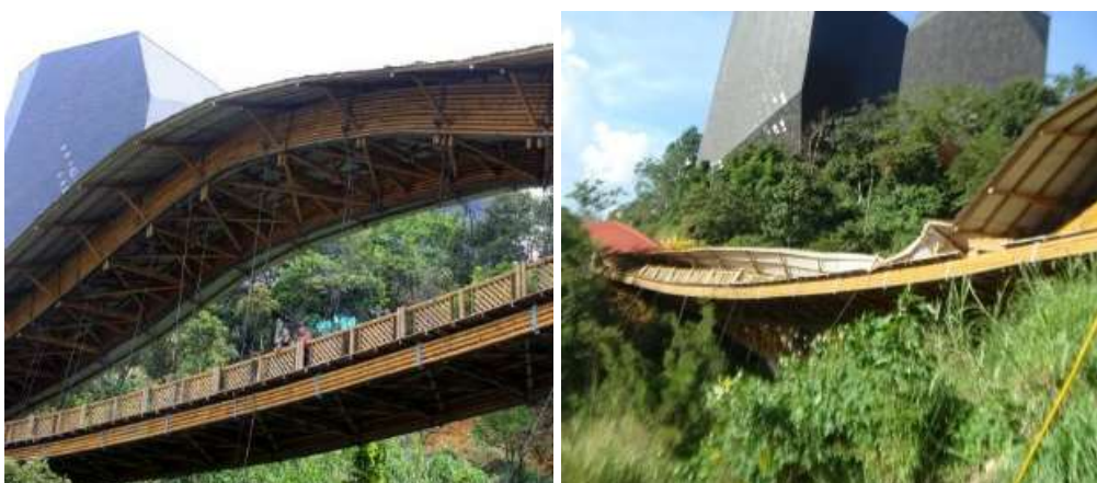
Figura 24: Fotos da Ponte de Santo Domingo de Savio antes e depois.
