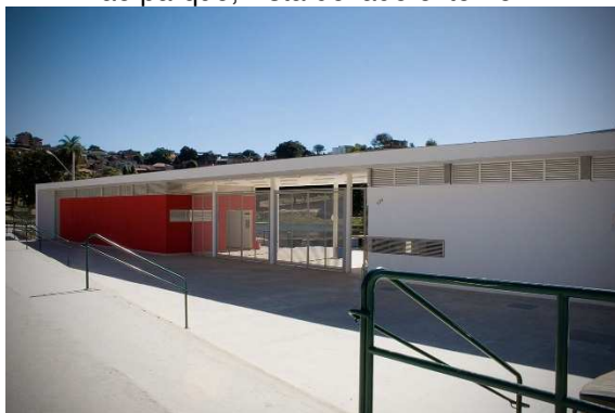
Figura 161 - Edificação localizada no acesso ao parque, vista do lado externo
