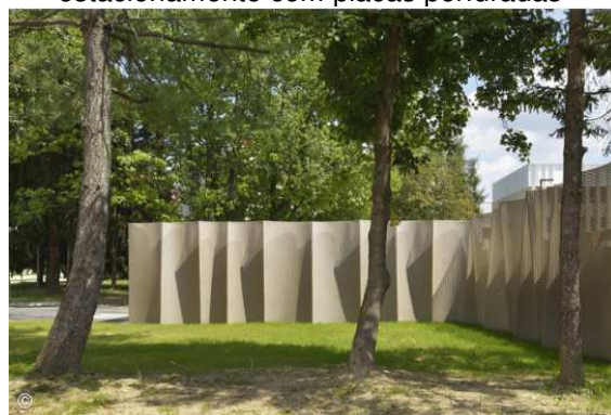
Figura 112 - Fechamento lateral do estacionamento com placas perfuradas
