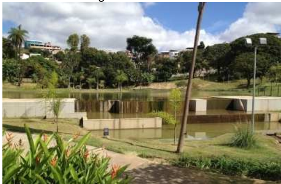
Figura 156 - Vertedouro do lago com quedas de água sucessivas
