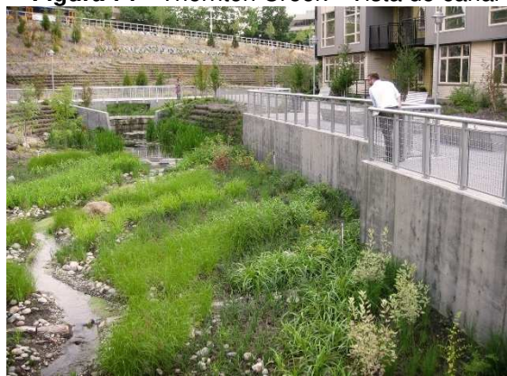
Figura 71 - Thornton Creek - Vista do canal
