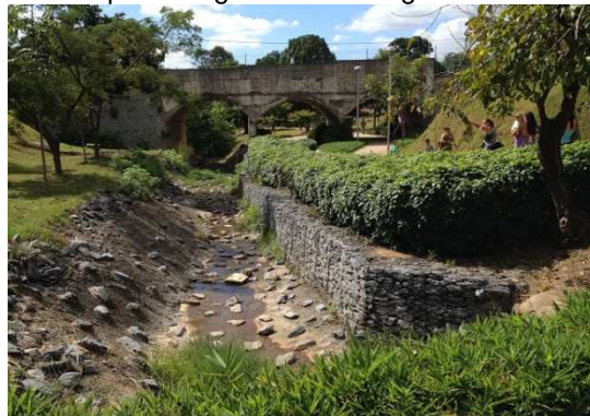
Figura 157 - Revestimento do leito e canal em pedra e gabião na margem direita
