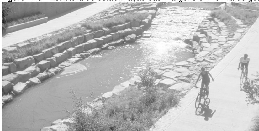
Figura 129 - Estrutura de estabilização das margens em forma de gota
