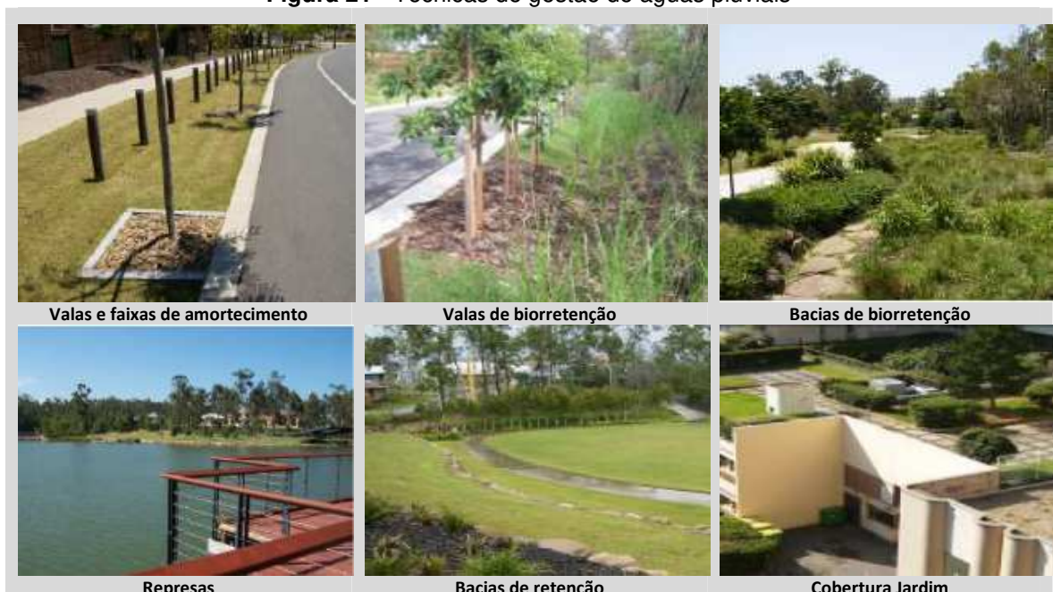
Figura 21 - Técnicas de gestão de águas pluviais
