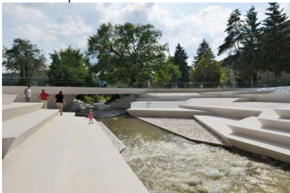
Figura 107 - Imagens do anfiteatro, ao fundo a nova ponte de travessia do Rio Paka
