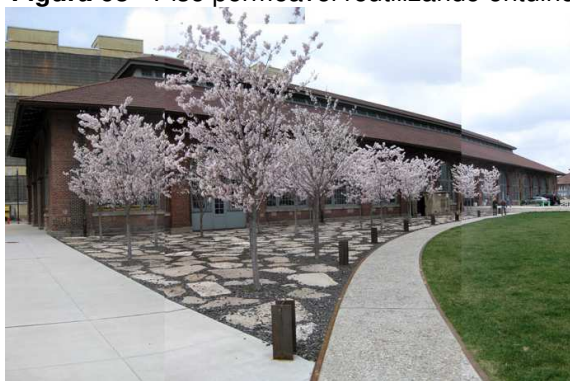
Figura 63 - Piso permeável reutilizando entulho
