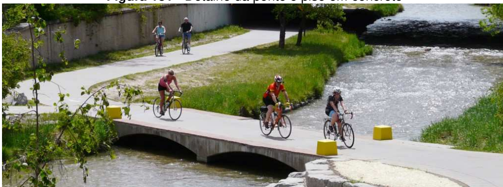
Figura 131 - Detalhe da ponte e piso em concreto
