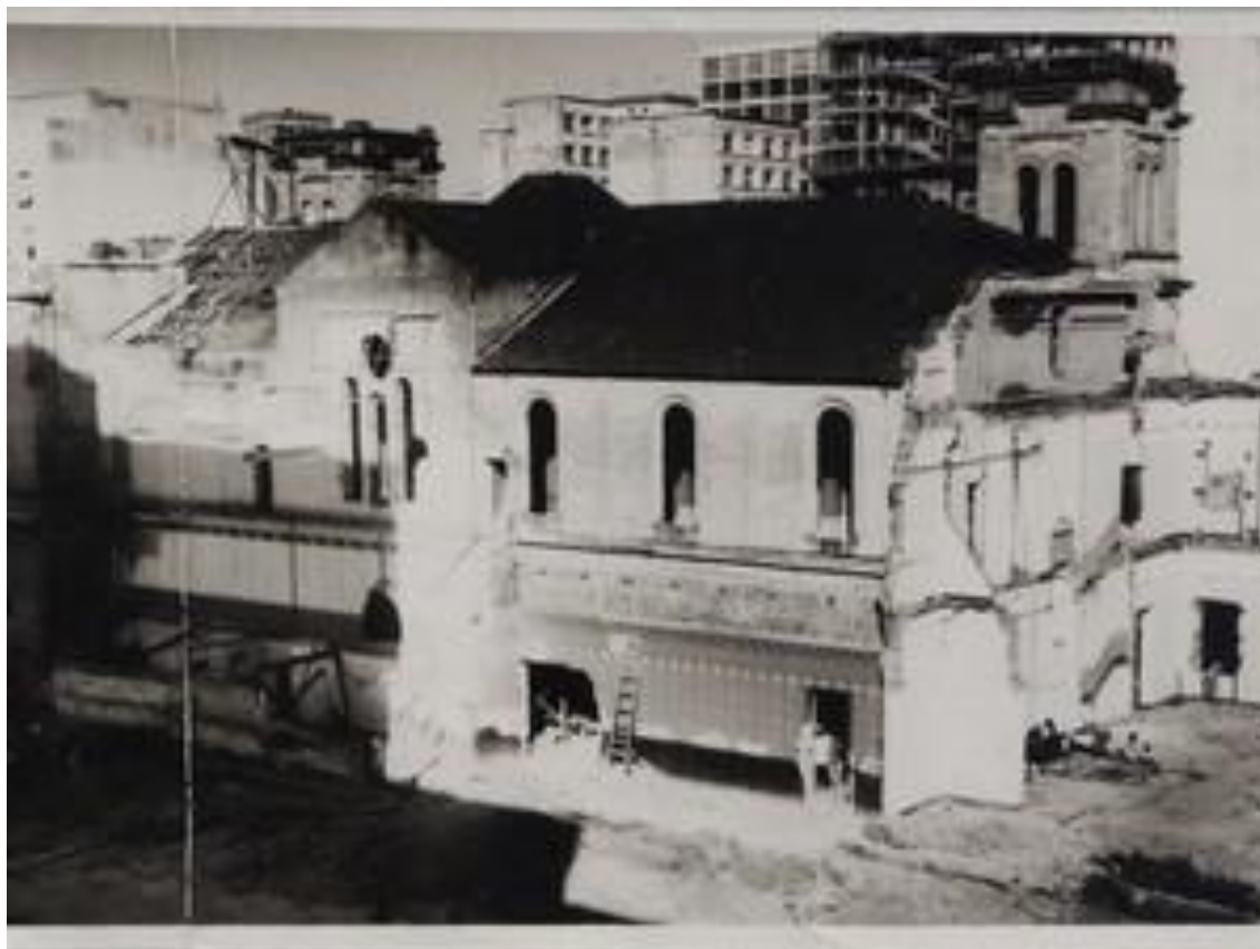
Figuras 7-8: destruição da Capela/Igreja do Rosário.
