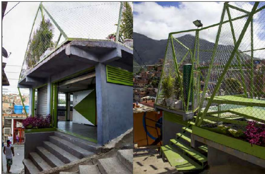
Figura 31 - Entrada da intervenção Núcleo Cultural La Ye
