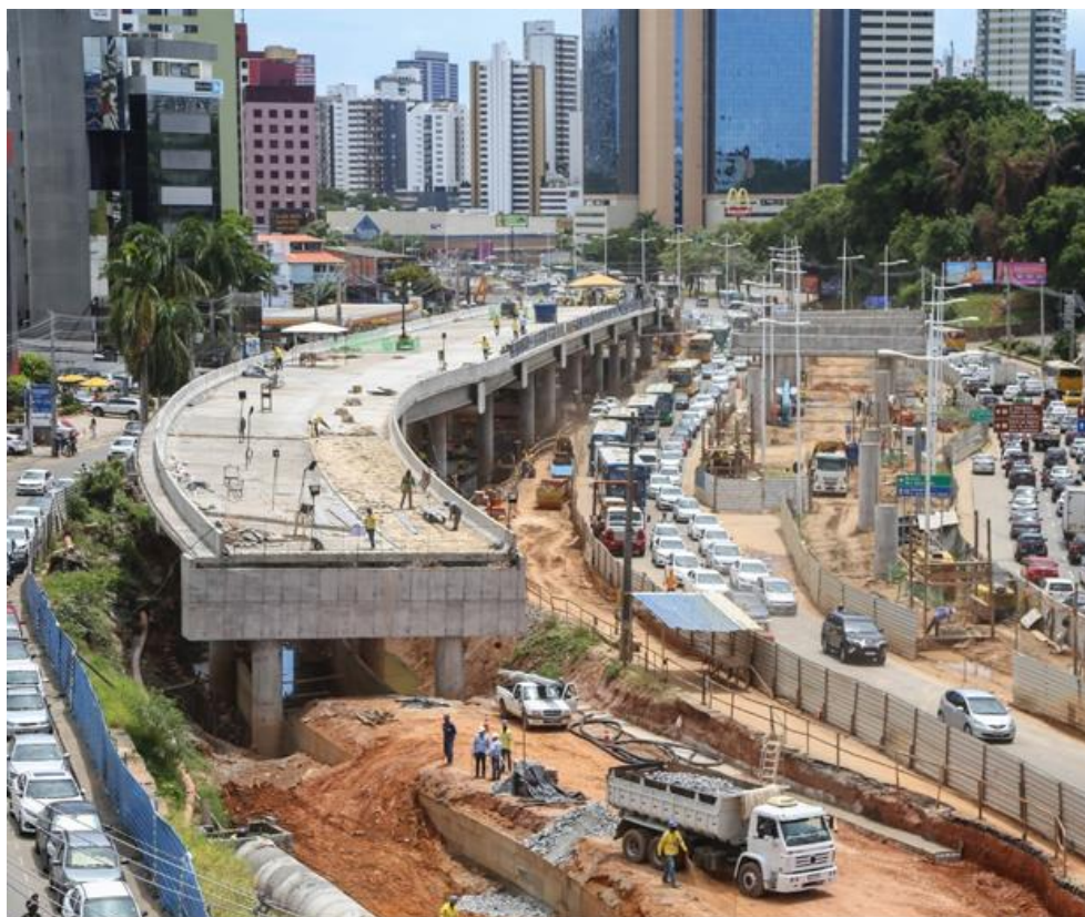
Imagem 35 – Obras do BRT na Av. Antônio Carlos Magalhães.
