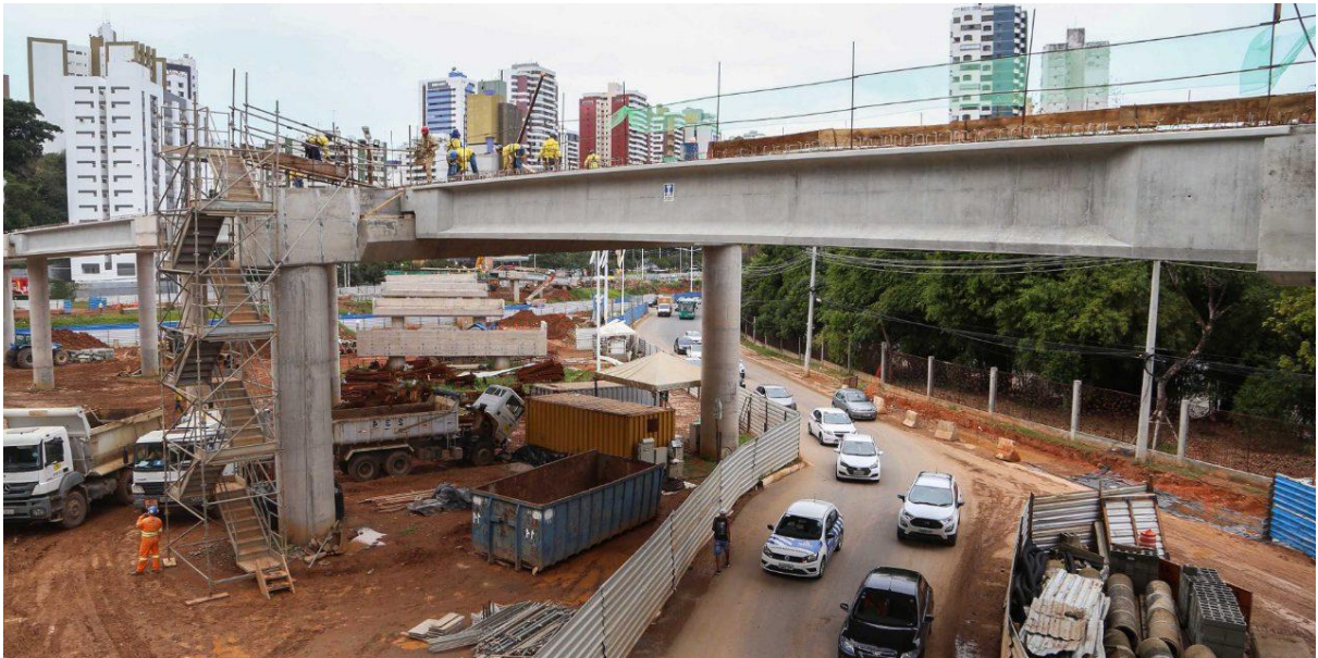
Imagem 34 – Obras do BRT na Av. Antônio Carlos Magalhães.
