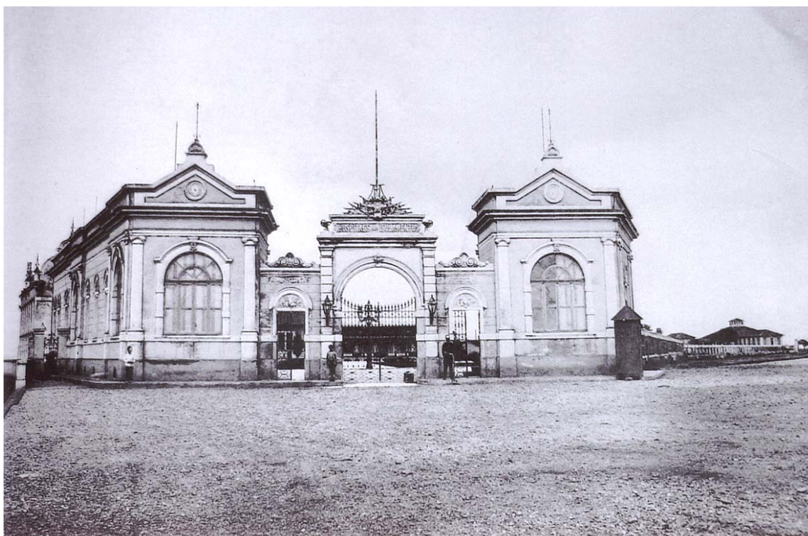
Figura 13 - Hospital de Isolamento – Portão de entrada na confluência da Estrada de Pinheiros com o edifício da administração (à esquerda) e o edifício da portaria (à direita).
