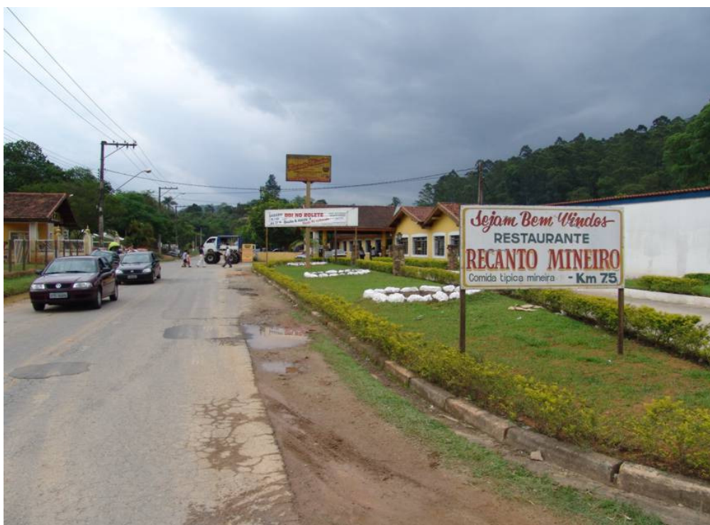
Figura 44 : Reta dos restaurantes construídos sobre a várzea do Ribeirão São Pedro
