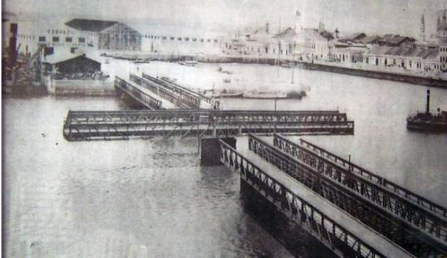
Fig. 49 Ponte Giratória de 1923. Apesar de não ser mais giratória, continua com seu lado direito da figura abrigando a passagem de trem, que sempre fez a ligação de produtos do continente com os galpões do porto. Ela demonstra a busca de soluções entre uma sobreposição de sistemas de transportes ferroviários, terrestres e fluviais.
