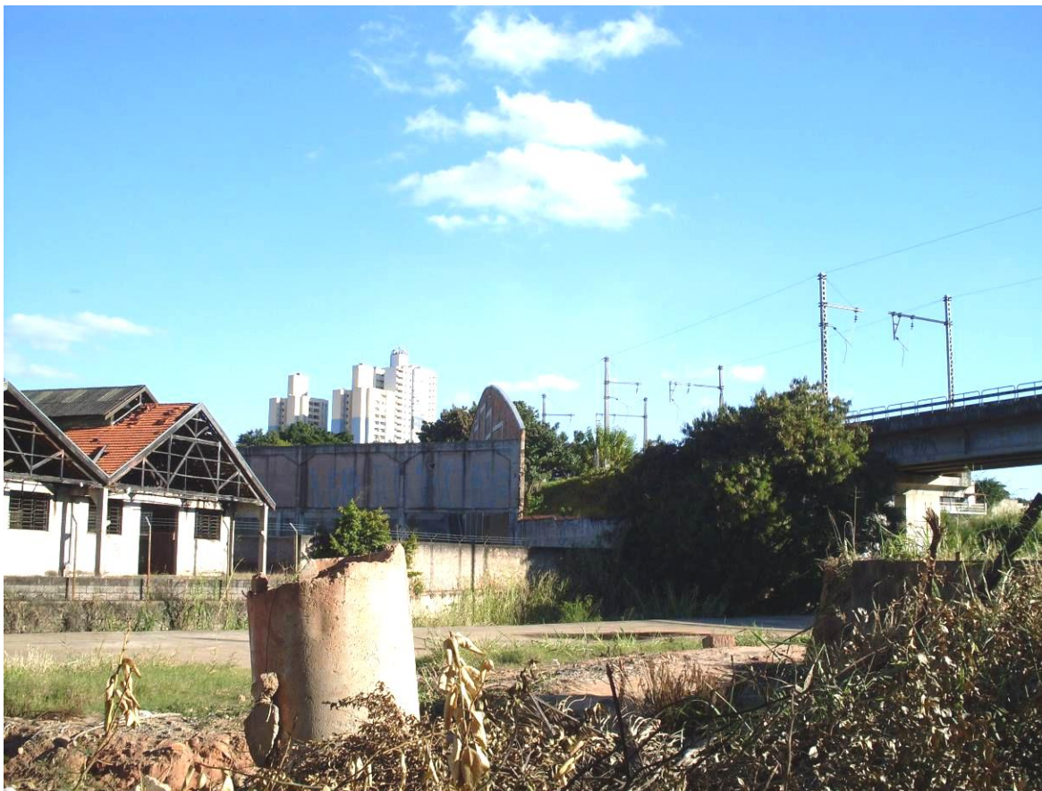
Fig. 31 - À esquerda o curtume Firmino Costa e a direita o leito ferroviário passando sobre viaduto próprio. Fonte: Pablo Costa. Campinas 2009.
