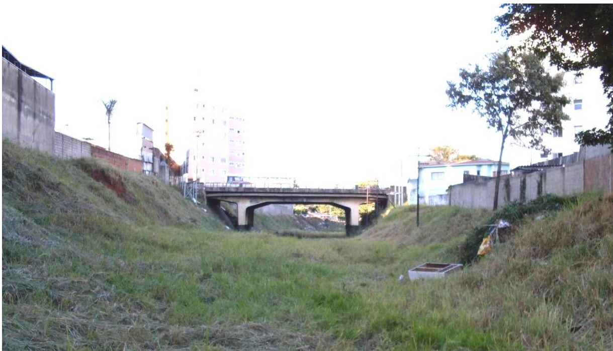
Fig. 45 - Leito da Cia. Mogiana desimpedido /. Em suas laterais o fundo dos lotes das residências e ao fundo a ponte sobre a av. Andrade Neves Fonte: Pablo Costa. Campinas 2009
