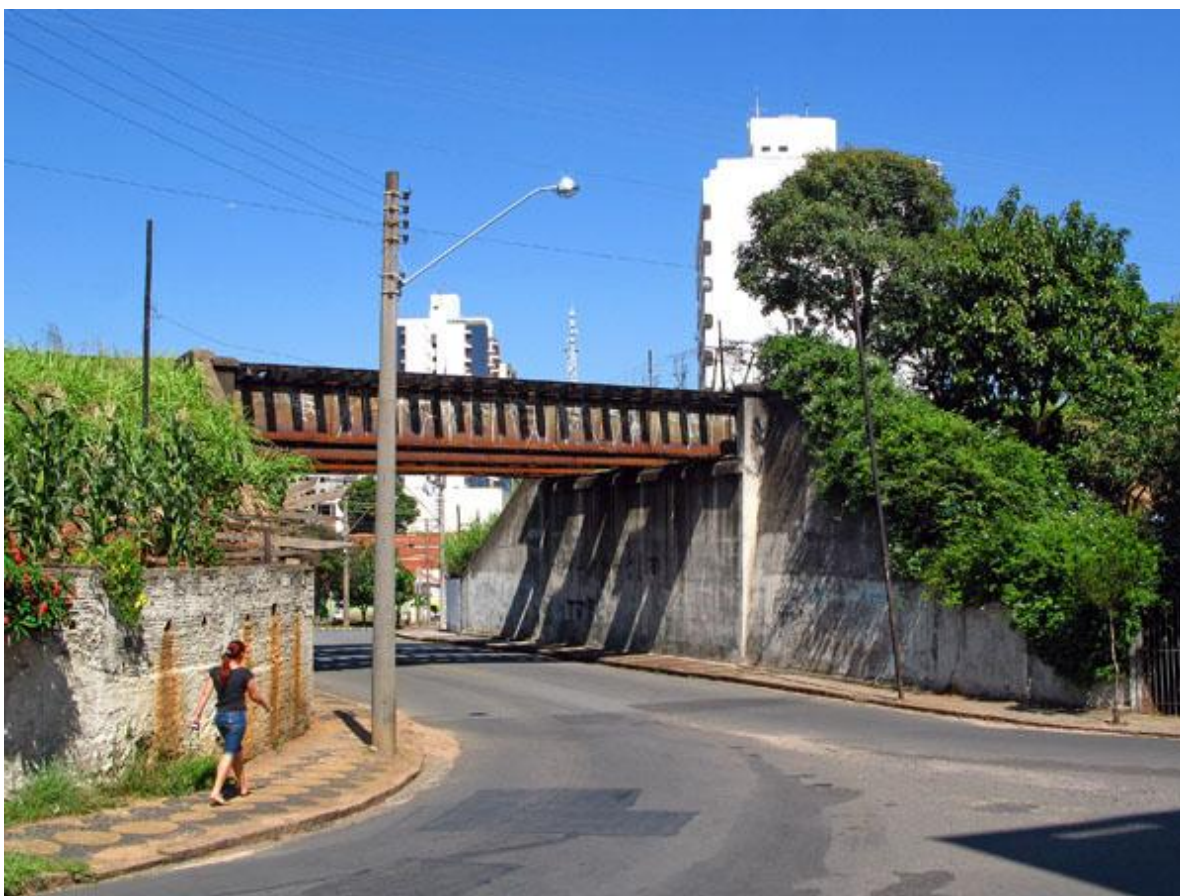
Fig. 46 - Ponte da Cia. Mogiana sobre a rua Joaquim de Campos Jr. Fonte: Eduardo Dantas. Campinas 2008
