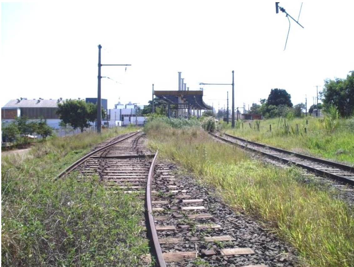
Fig. 21 – Estação VILA TEIXEIRA – Fonte: Pablo Costa. Campinas 2009
