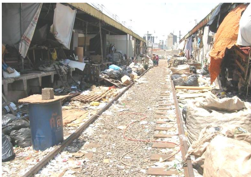
Fig.19 - Estação BARÃO DE ITAPURA (atual cooperativa de reciclagem)
