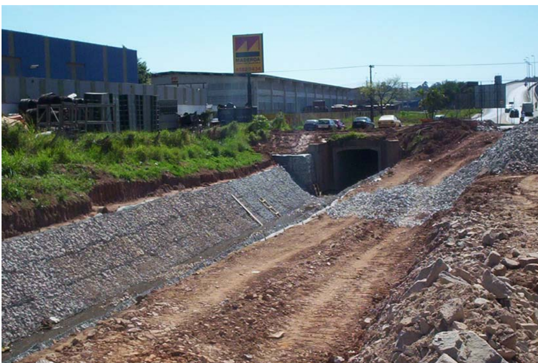
Figura 14 – Canalização do Córrego do Jardim Guanabara
