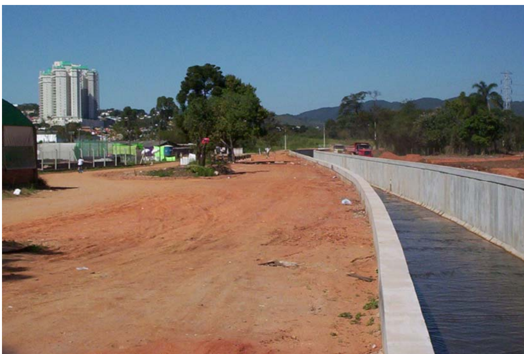
Figura 12 – Canalização do Córrego das Walquirias
