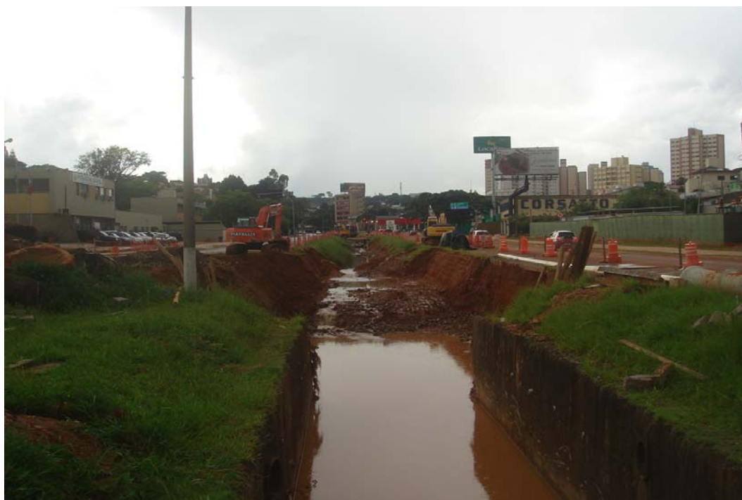
Figura 15 – Obras na Avenida 9 de Julho
