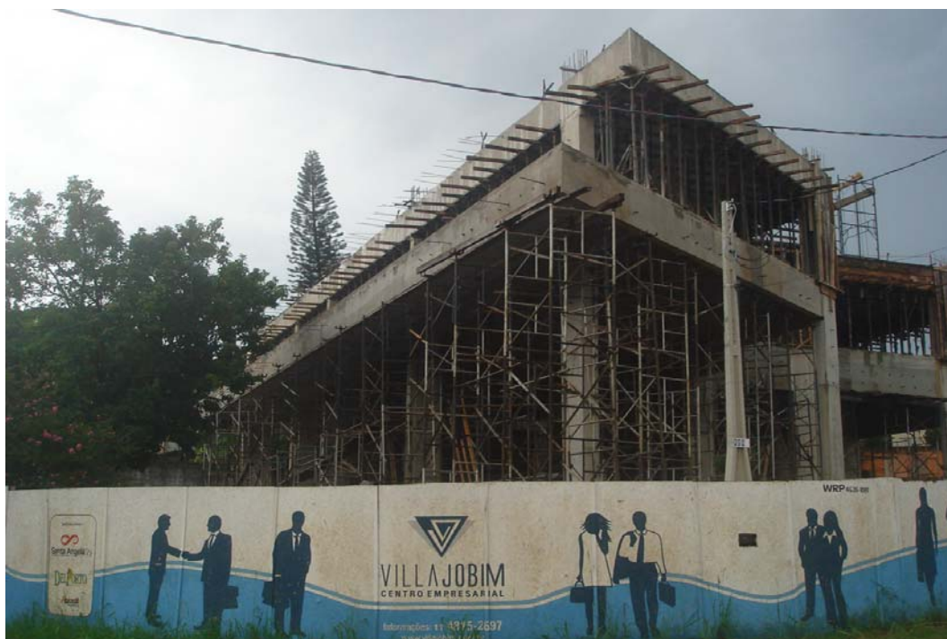
Figura 17 – Construção de Centro empresarial próximo à Avenida 9 de Julho
