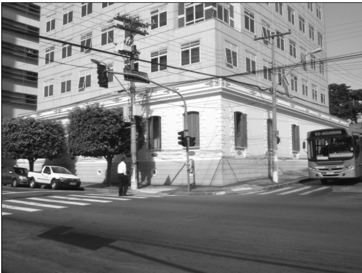
Figura 3 – Edifício construído a partir de manutenção da fachada histórica. Av. Andrade Neves, ao lado da antiga Rodoviária (Fotografia do autor).
