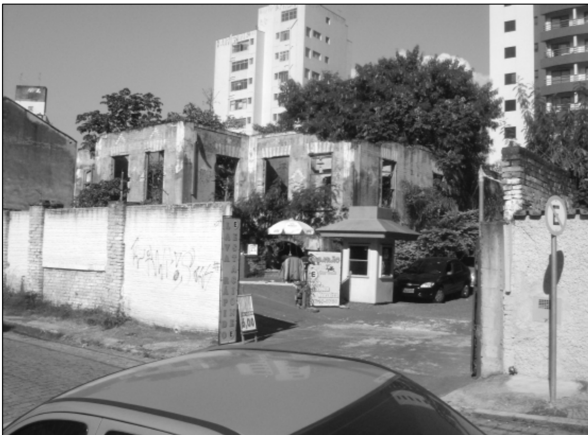
Figura 1 – Ruínas de imóvel residencial situado à Rua Ferreira Penteado, em sua última quadra (Fotografia do autor).
