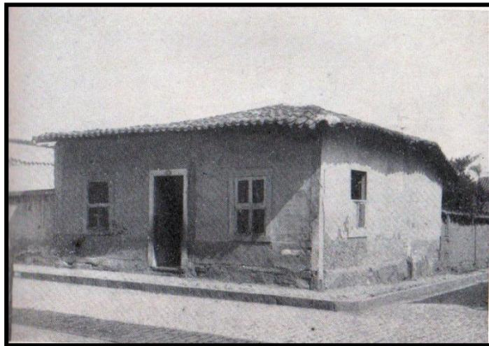
**Figura 2.9.** Antiga casa em Campinas construída em taipa-de-mão. Esta técnica fora condenada pelo Código de Posturas da Câmara Municipal de Campinas, de 1880, pois não seguia “o gosto e arquitetura das construções modernas”. Fonte: MENDES, José de Castro. Retratos da Velha Campinas, p.163.
