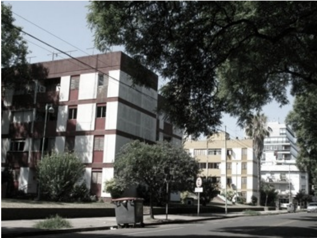
Figura 34. Foto atual do Conjunto Urbano La Pampa I. Fonte: Levantamento próprio, 2012.
