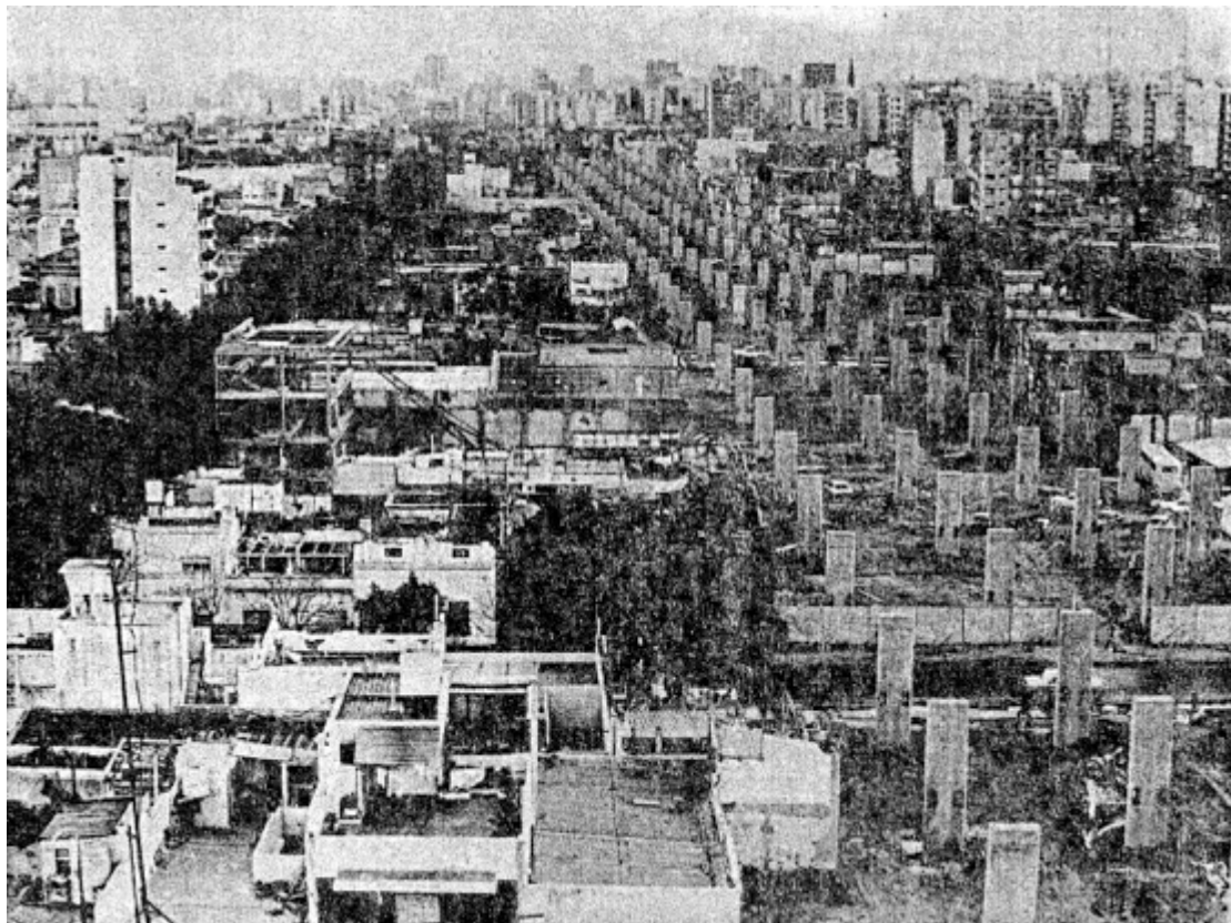
Figura 74. Autopista 25 de Mayo em construção, atravessando pelo meio dos quarteirões construídos. Fonte: ZICOVICH WILSON, 1983.
