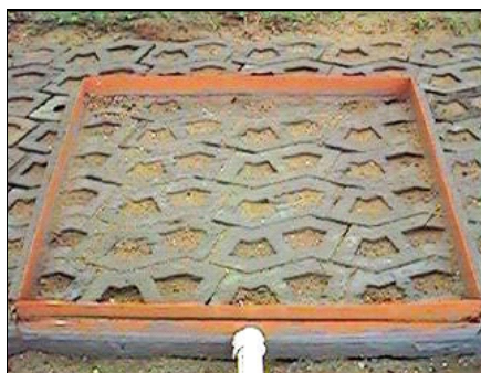
Ilustração 14 - Pavimentos Porosos. Fonte: IPH apud Yazaki, 2004
