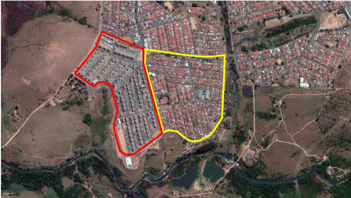
Figura 7 - Região Sudoeste - condomínios MCMV Jardim Bassoli e conjunto habitacional Parque Itajaí, em 2017. FONTE: Google Earth.
