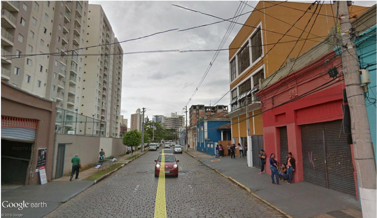
Figura 13 - Condomínio Vertical Central Park Home Resort, exemplo de verticalização multifamiliar na região Centro-Sul. FONTE: Google Earth.
