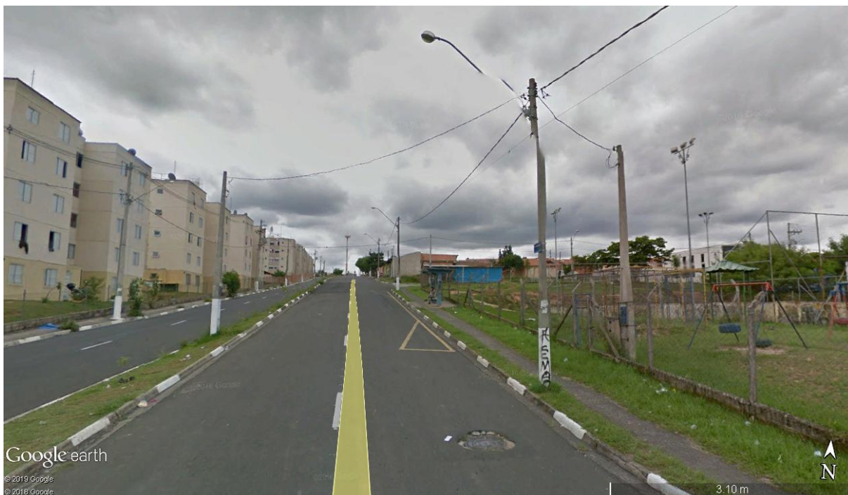
Figura 8 - Condomínios MCMV Jardim Bassoli à esquerda e espaços públicos do Parque Itajaí à direita. FONTE: Google Earth.
