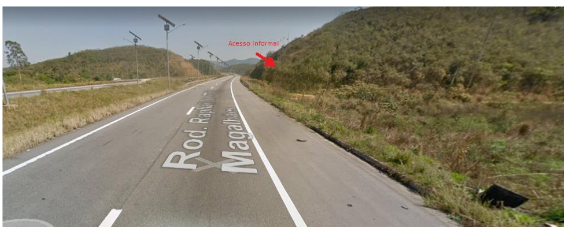
Figura 52 – Acesso informal no Município de Queimados.
