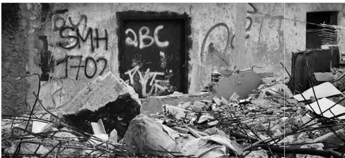
Figura 14 – Escombros de casas demolidas após remoção das famílias, na área da Cruzeiro, Morro da Providência.
