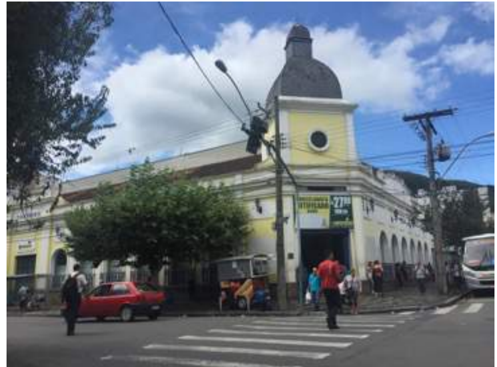
Figura 64: Fachada da Casa Carneiro hoje, com a preservação da torre central e modificação das fachadas laterais. Vê-se a ocupação desordenada da calçada, com a presença de carrinhos de lanches e pontos de ônibus. Fonte: Acervo da pesquisa.
