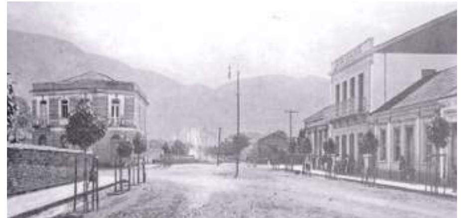
Figura 23: Imagem Rua Marquês do Paraná em 1914. A imagem destaca a via, com seus 20 metros de largura, dimensão proposta pelo plano de 1872. Nessa imagem a arborização das vias parece recente, com a vegetação ainda pequena e escorada. No centro do leito carroçáveis vêm-se postes de iluminação. As edificações são assobradadas e à direita lê-se “Casa Lealdade”, edifício comercial preservado ainda hoje. À esquerda, residência assobradada também preservada hoje, porém como edifício comercial. Fotografia: Autor desconhecido. Acervo: Décio Alves de Moraes.
