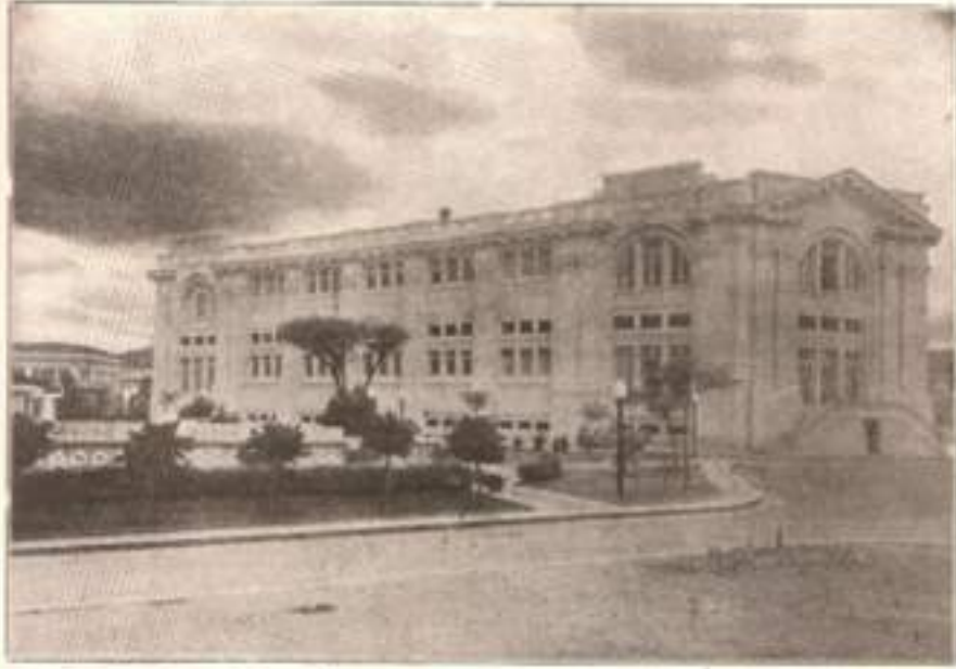
Figura 78: Edifício das Termas Antônio Carlos em 1931. Do lado esquerdo a Praça Dr. Elisirário Junqueira. Fonte: Museu Histórico e Geográfico de Poços de Caldas.
