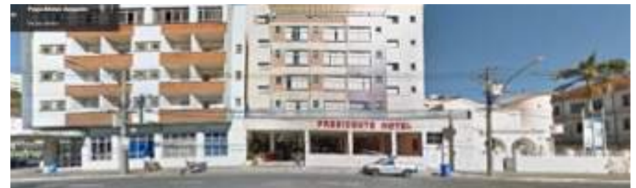
Figura 38: Imagem Panorâmica de parte da Rua Junqueiras, pertencente à Área Característica 01, que demonstra a diferença dos gabaritos de altura entre dois edifícios de hotéis (à esquerda), com mais de quatro pavimentos, e de um imóvel inventariado o antigo Pronto Atendimento da
