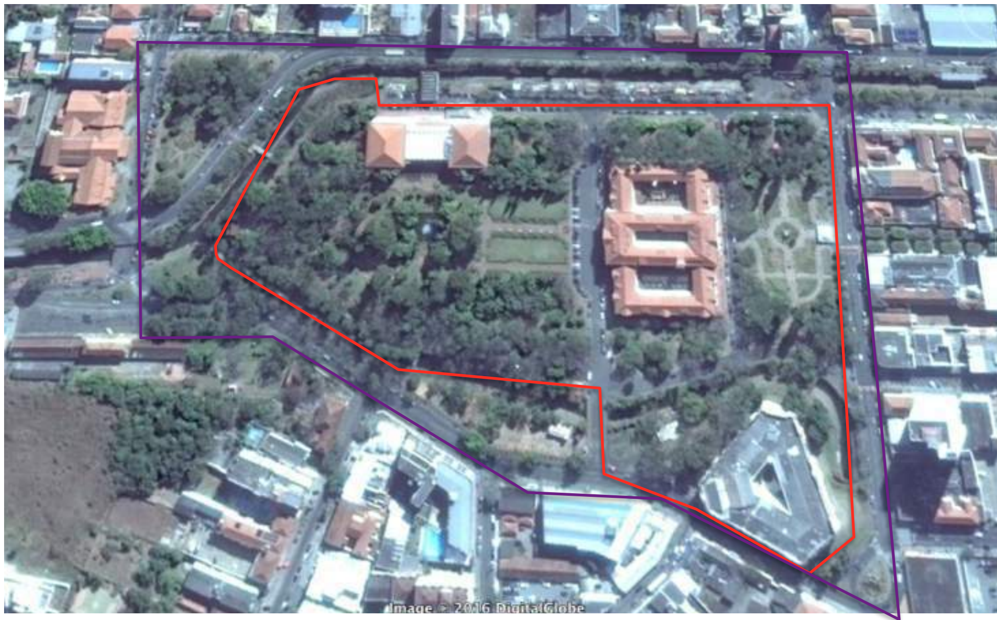
Figura 73: Imagem aérea atual do Complexo Hidrotermal e Hoteleiro com os dois perímetros de tombamento. Em vermelho o tombamento Municipal e em roxo o tombamento estadual. Fonte: Google Earth - Disponível em: < https://www.google.com/maps/place/Poços+de+Caldas+++MG,+Br...
