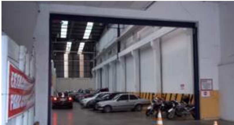
Figura 62: Interior da “Casa Carneiro” que atualmente apropriou parte de seu imóvel como estacionamento de estrutura metálica. Fonte: Acervo da Pesquisa
