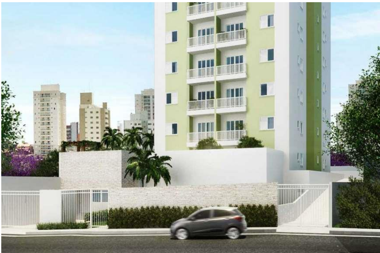
Figura 27: Fachada do empreendimento Kamimura. Fonte: Divulgação.
