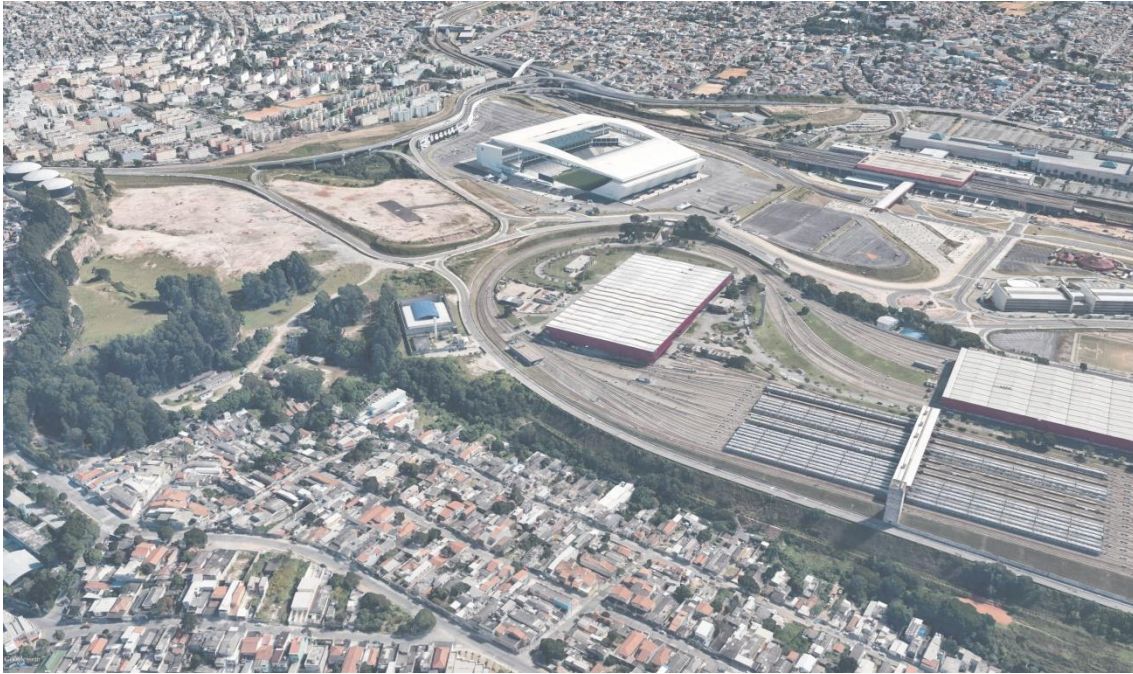
Figura 35: Vista aérea atual. 2018 Google.
