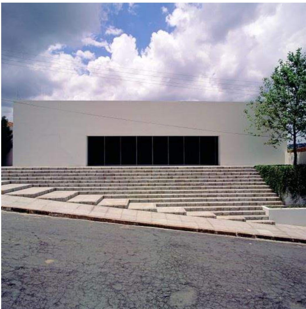
Figura 30. Instituto Moreira Salles, Poços de Caldas/MG - Projeto de Aurélio Martinez Flores. Disponível em: http://www.vitruvius.com.br/media/images/magazines/grid_9/3e8429edc128_flores_03_casadecultura.jpg . Acesso em 15/10/2018.
