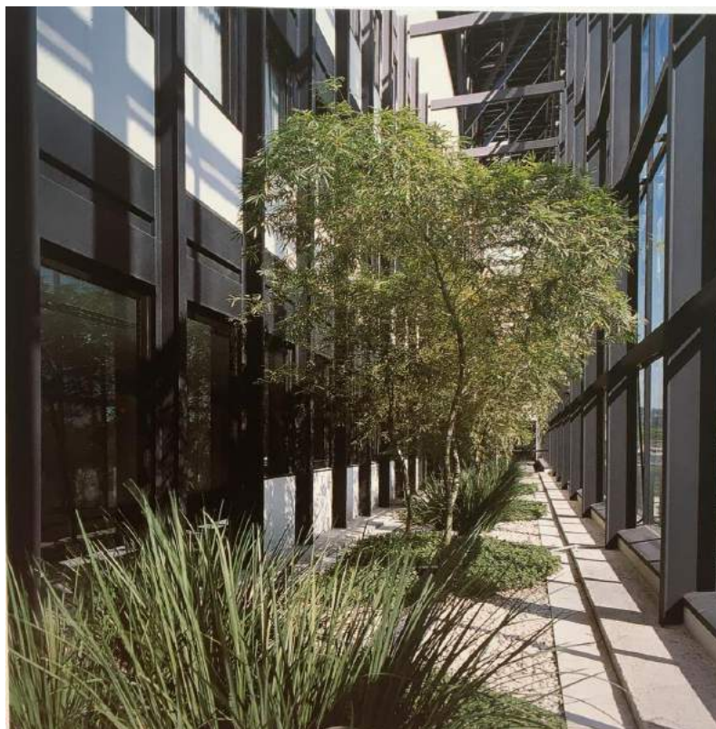
Figura 53. Interior do Edifício-sede da Mineração Itaqui, de Aurelio Martinez Flores. Na imagem é possível notar o distanciamento entre as duas camadas de vidro propostas pelo arquiteto e a criação de um jardim neste intervalo. Fonte: LAGO, 2001, p.109
