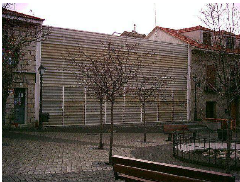
Figura 1. Sala Municipal de Colmenarejo, Espanha. Disponível em: https://www.via-arquitectura.net/12/12-044.htm
