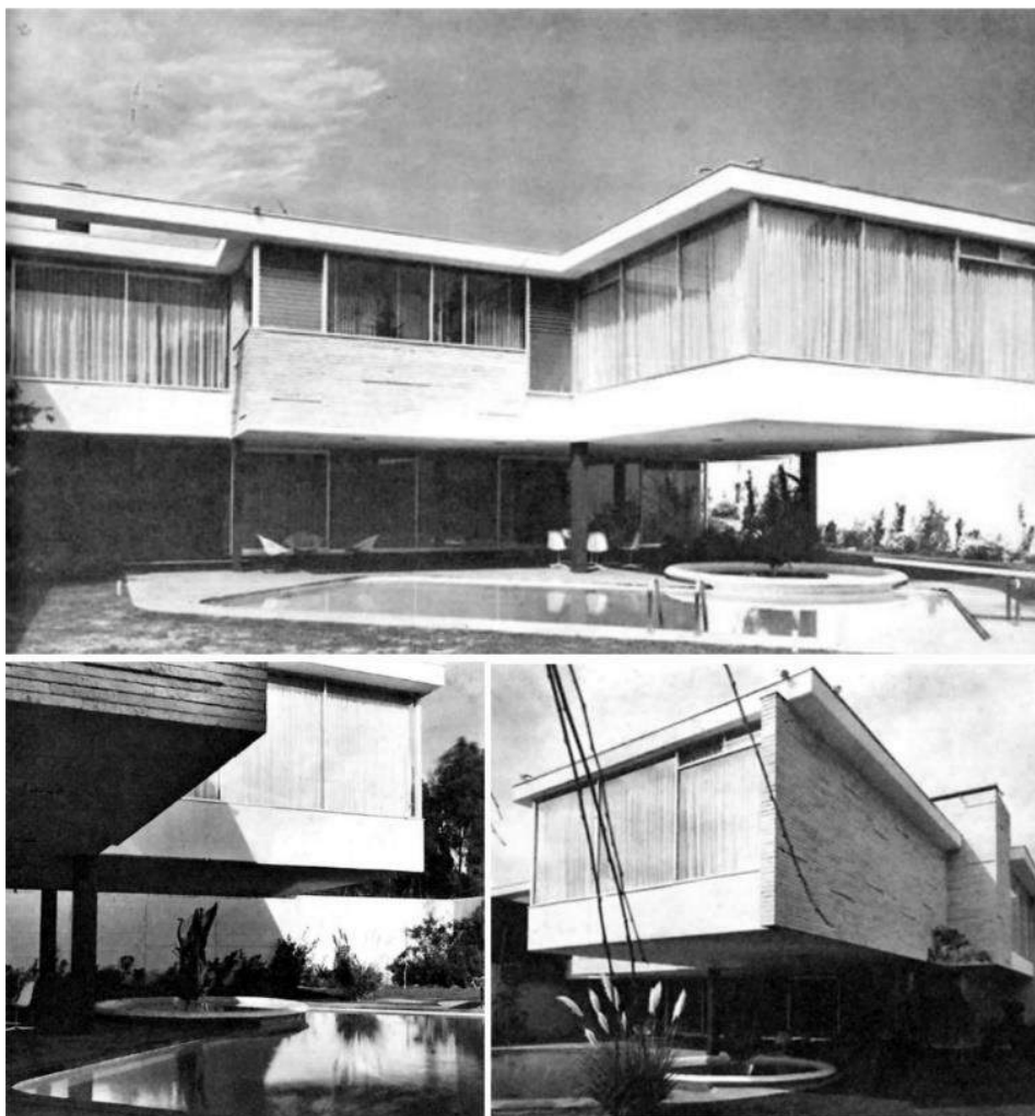
Figura 23. Colagem de fotos da Casa em Lomas, Sierra Mestañas, Cidade do México 1962. Projeto de Jorge Gonzalez Reyna, a partir do acervo digital “Una vida moderna”. Grandes panos de vidro fazem o fechamento da residência e as áreas em balanço garantem o sombreamento das áreas de permanência da residência. Disponível em < https://unavidamoderna.tumblr.com/ > Acesso em 15/05/2020
