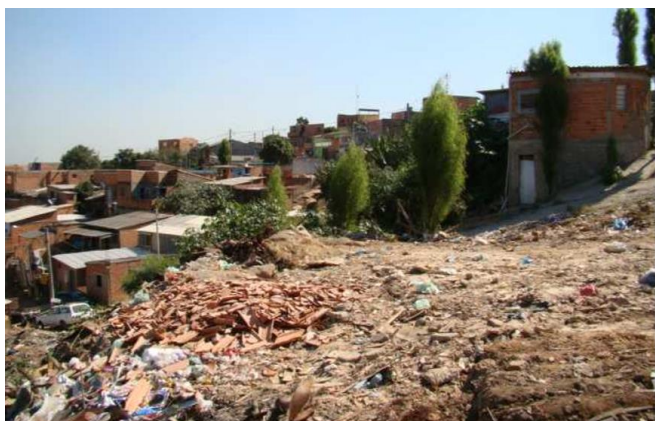
Figura 8: Encostas densamente ocupadas e ausência de sistemas de drenagem
