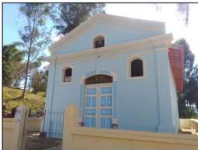
Figura 127: Capela do Belém em processo de restauro, 2018. Fonte: Autora, 2019.
