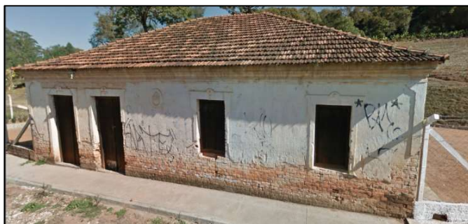
Figura 98: Foto (2020) da edificação da Casa de “quentes e frios”, construída por Antônio Fornari por volta de 1900, hoje distante 1,5 quilômetro do centro de Pinhalzinho. Fonte: Google Street View.
