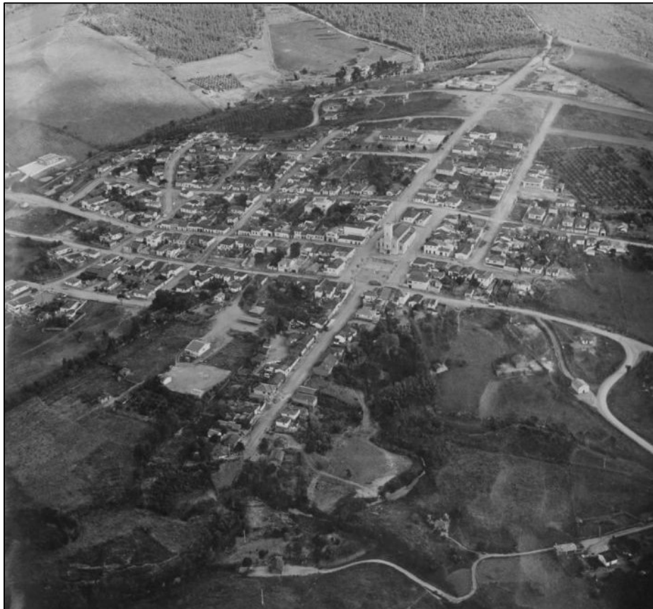
Figura 100: Foto oblíqua da cidade de Pinhalzinho, 1970. Fonte: IGC.
