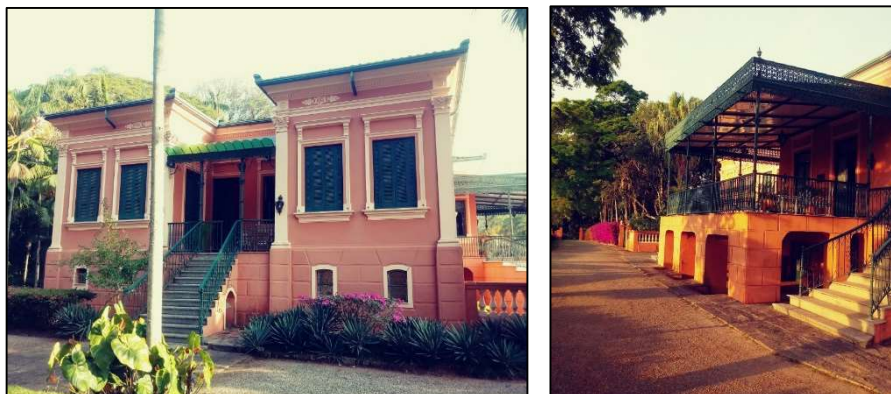
Figura 116: Fachada principal da sede da Fazenda Caethé. Fonte: Autora, ago. 2019.
