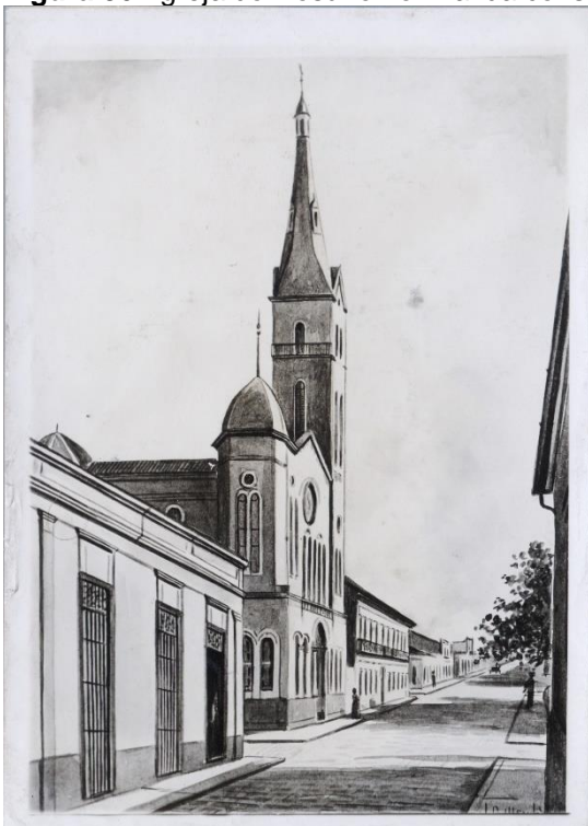
Figura 56: Igreja do Rosário no final da construção em 1910.
