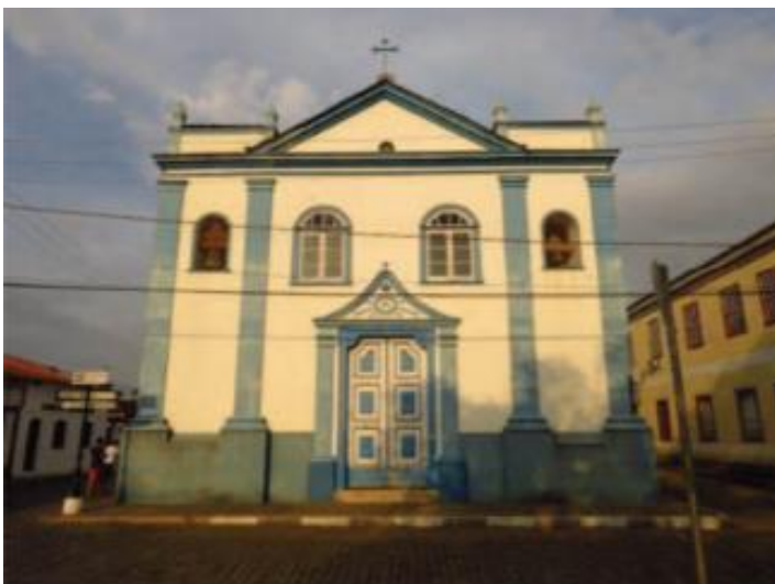
Fonte: STREET VIEW, 2021.
