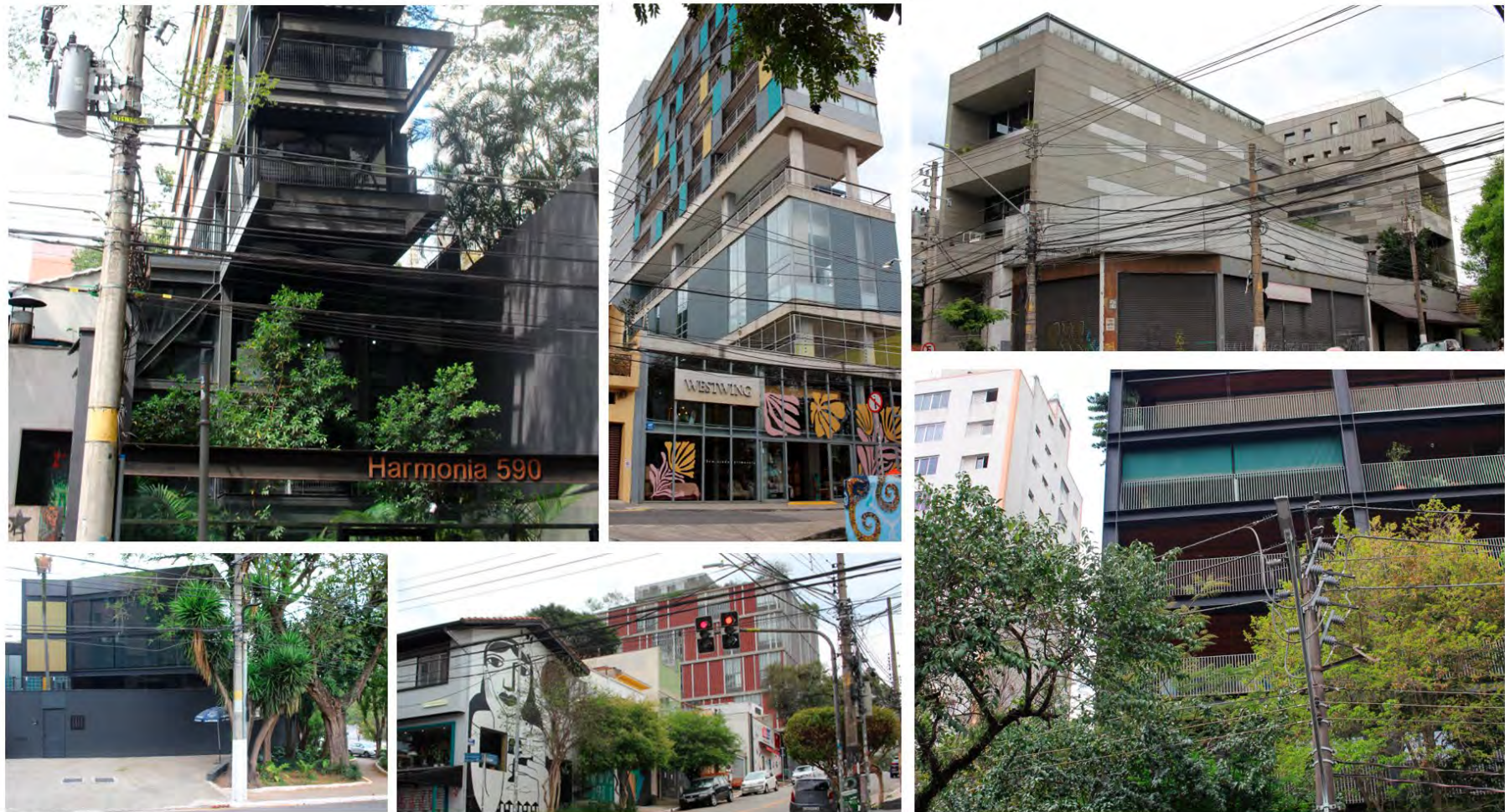
Figura 26: Edifícios da IdealZarvos localizados na Vila Madalena, vistos em Trabalho de Campo exploratório. Fonte: imagens próprias
