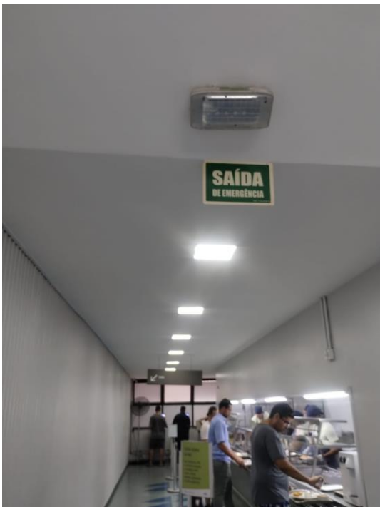
Figura 15 - Refeitório com iluminação de led com sensores de presença.
