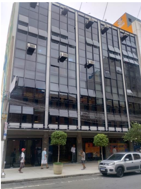
Figura 7 – SESC CEDEI: Fachada do prédio toda em vidro para facilitar a entrada da luz e produzir uma iluminação natural. Janelas com ampla abertura para ventilação natural.
