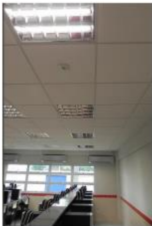
Figura 12 – CEEWH: Lâmpadas LED e luminárias reflexíveis com controle de acionamento por fileira.
