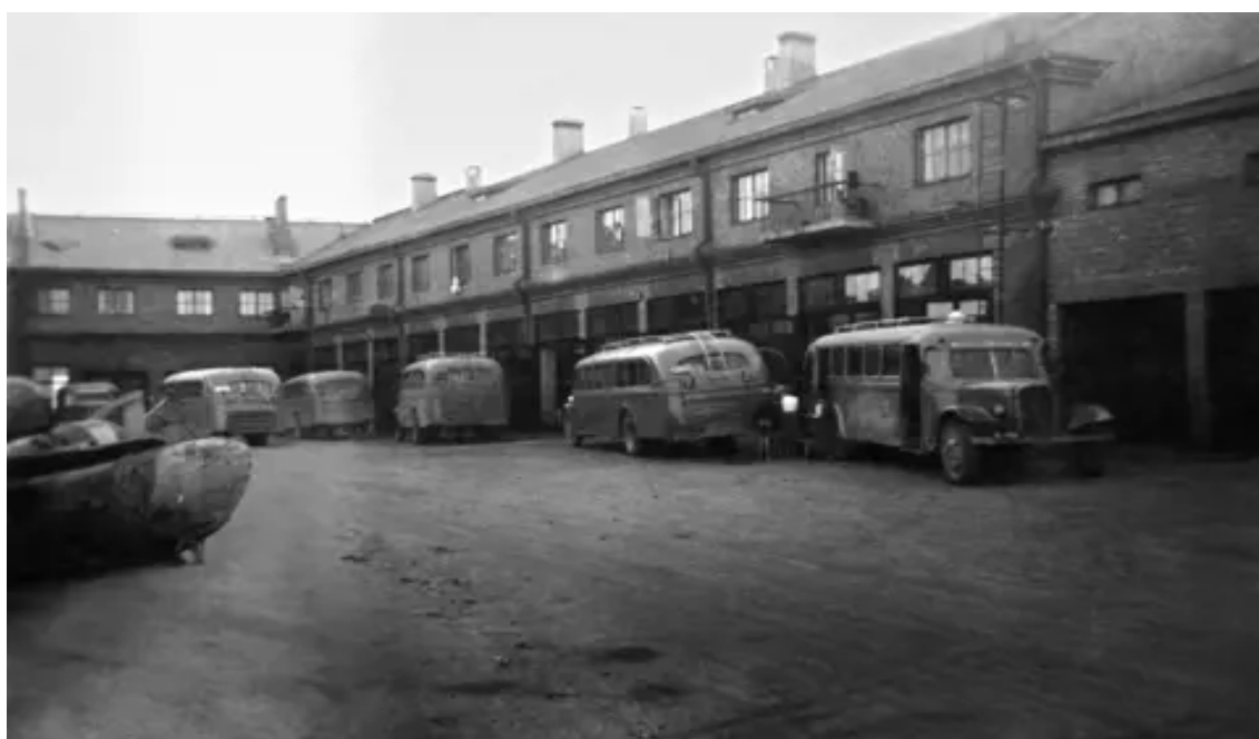
Figura 7 - O antigo depósito de caminhões de correios parte externa do edifício.
