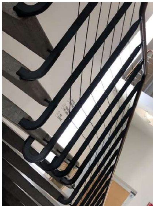
Figura 21 - Detalhe do corrimão em bronze e ferro.
