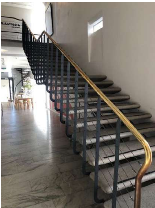
Figura 21 - Detalhe do corrimão em bronze e ferro.
