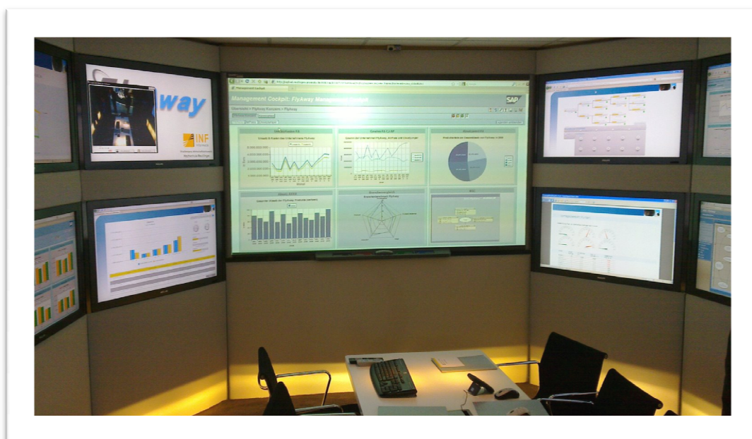
Sala ambiente com monitoramento por dashboards .
