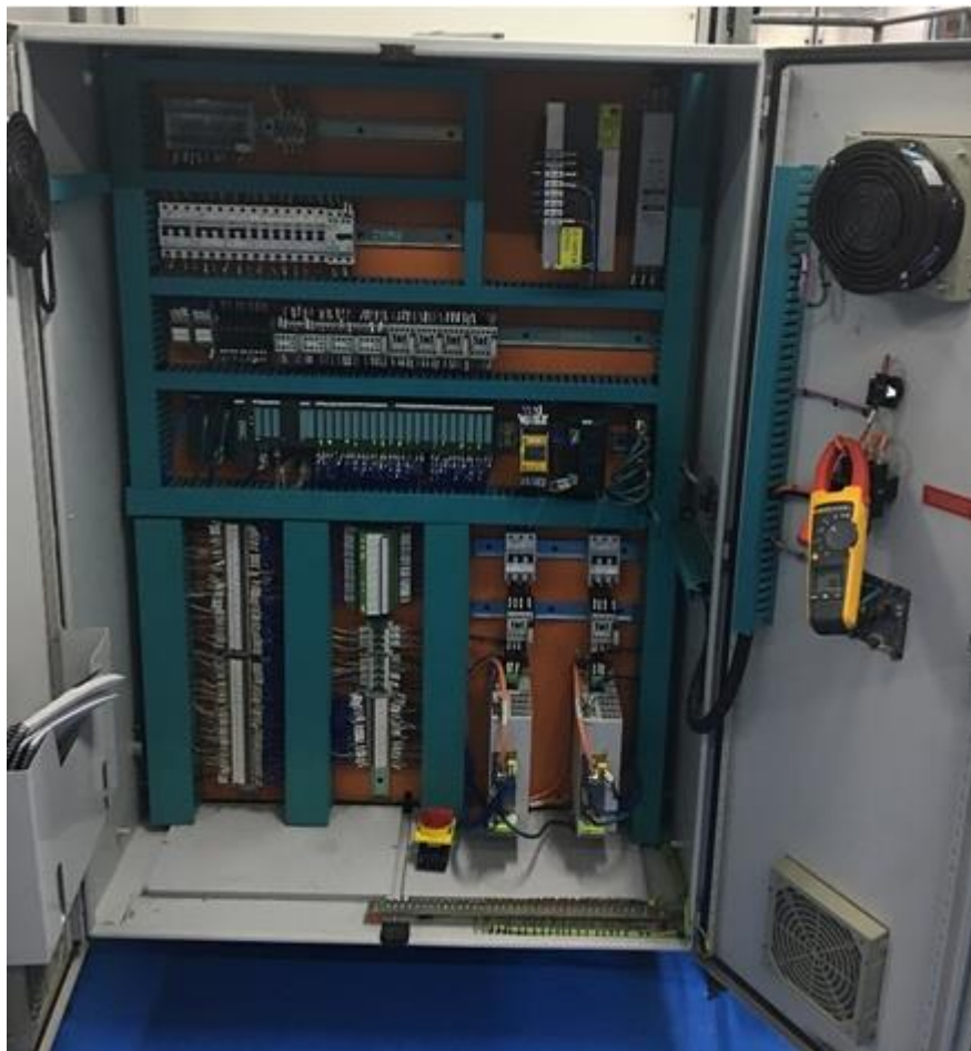
Figura 10 – Medida preliminar de consumo de corrente com amperímetro manual.
